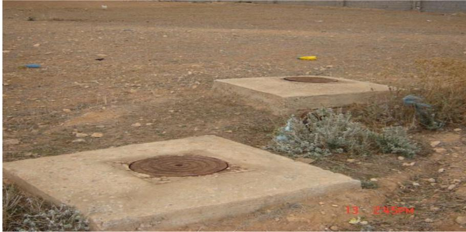
**Figure III.10 :** Photo des regards de visite des vannes sur la conduite d'amenée à l'entrée du réseau de distribution du centre. [10]
