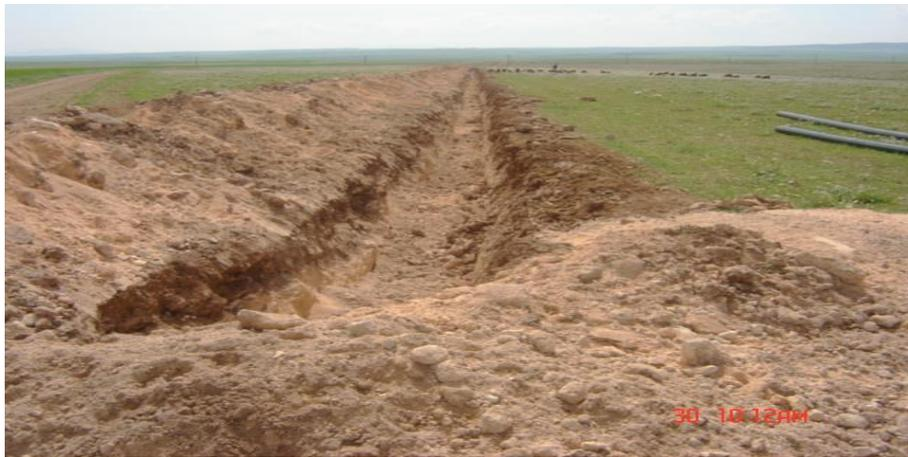
**Figure III.7 :** Photo de travaux de réalisation de la Tranchée de la conduite d'adduction projetée reliant le Forage DE6 au réservoir R1. [10]
