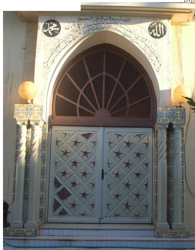
Porte de la façade nord en 2013. Photo prise par l'auteur
