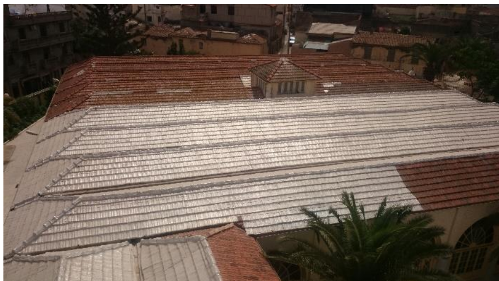
La couverture est composée de treize toits longs. Photo prise par l'auteur
