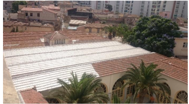
Photo N°2 : La cour à partir du minaret Prise par l'Auteur
