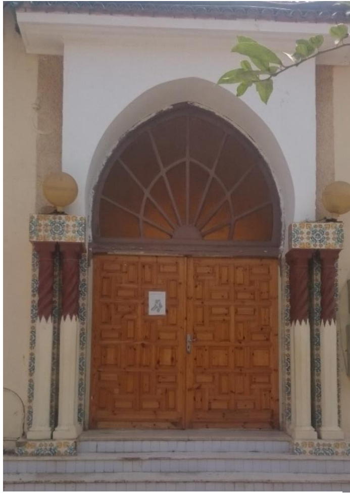
Porte de la façade nord. Photo prise par l'auteur
