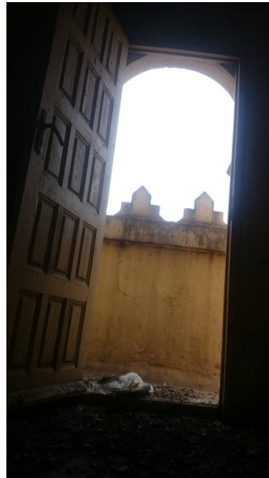
La porte du minaret de la mosquée. Prise par l'Auteur
