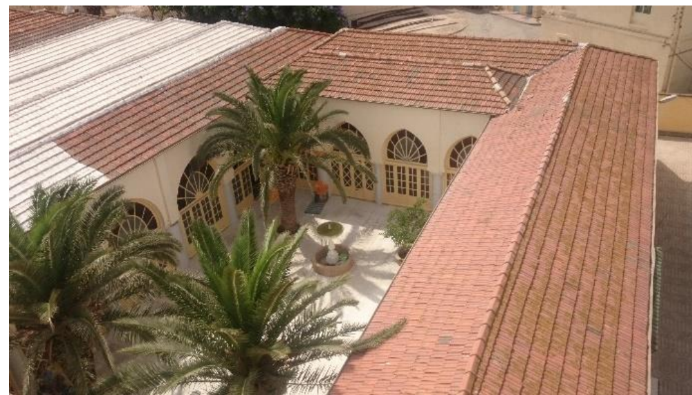
Les quatre pentes sont dirigées vers la cour. Photo prise par l'auteur.
