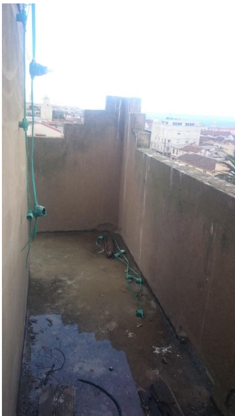
Photo haut du minaret (Prise par l'auteur)
