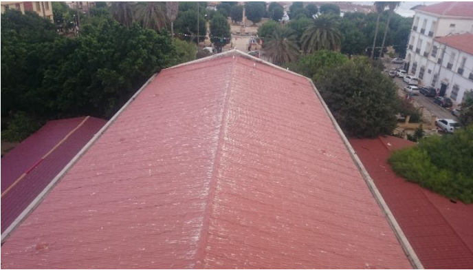
Vue d'en haut sur la toiture
