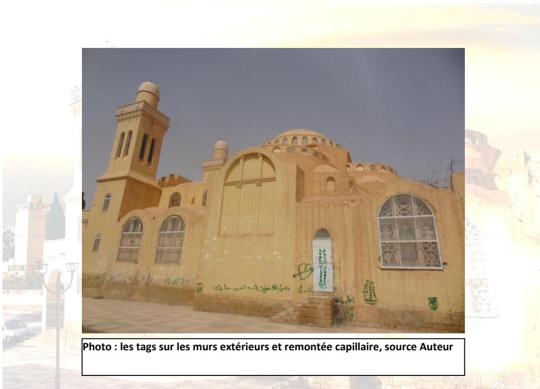
Photo : les tags sur les murs extérieurs et remontée capillaire, source Auteur
