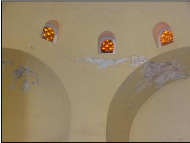
Photo : Fissure au niveau de la coupole
