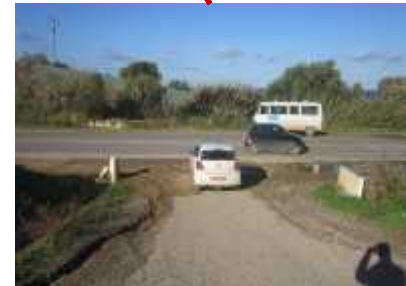
Image 136: Voie juste à gauche d'un cour d'eau
