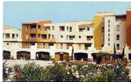
Image 38: décrochements dans la façade
