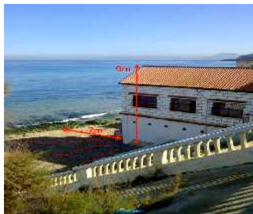
Image 43: habitat construit illégalement
