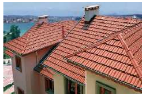
Image 23: Utilisation de toiture et les auvents
