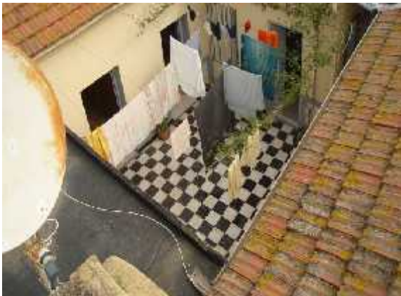
Image 67: Toiture rouge inclinée vers la cour
