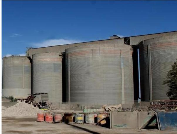
**Figure I.9 :** Silo de stockage de clinker.
