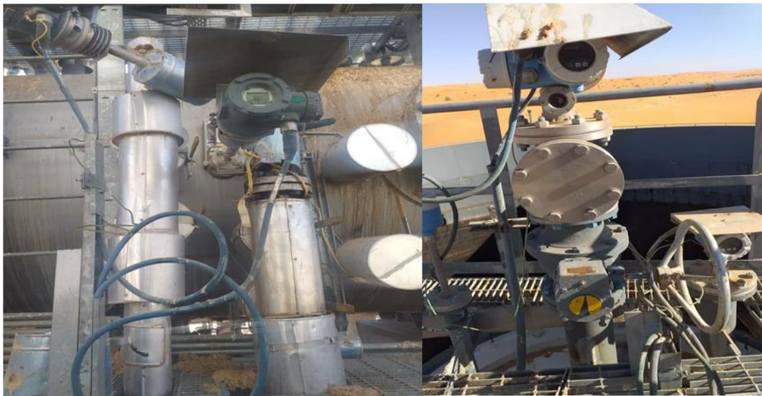
Figure 1.10 Transmetteur de niveau.
