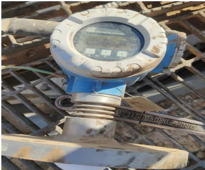
Figure 2.18 Installation du transmetteur au niveau du bac de stockage.
