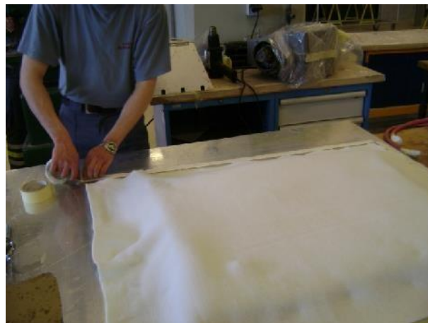
Figure III-16 : Dépôt d'une 2e feuille de feutre de drainage.
