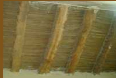
les poutres de plancher (solive en bois)
