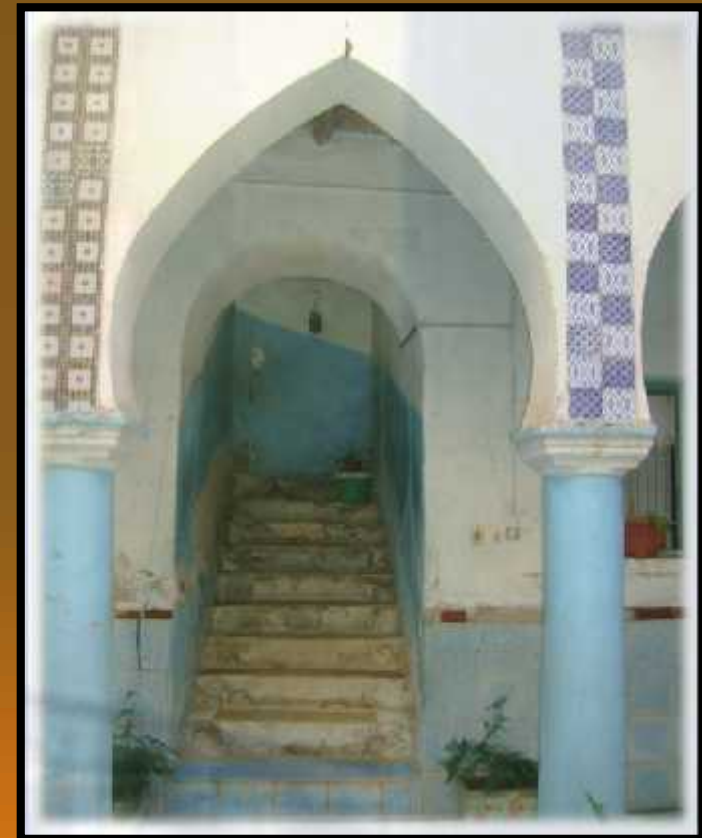
Escaliers en forme (U) au niveau de RDC
