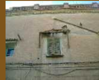
la chaux sur la façade principale
