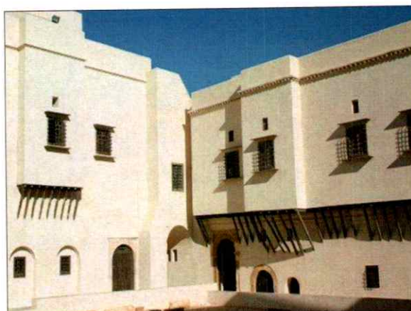
Fig. 2.17 La Casbah d'Alger. Src : PETRUCCIOLI. A, « Alger 1830-1930. Pour une lecture typologique des immeubles d'habitation ».
