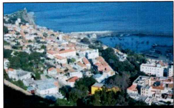
Fig.3.30- Rupture entre l'entité coloniale et médiévale. Src : Auteur 2015.
