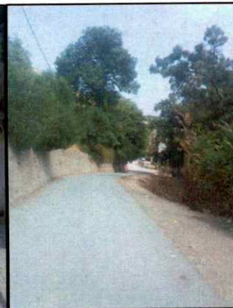
Fig.3.42- Vue sur la rue, côté ouest du site.
