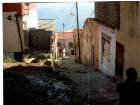
Fig. 2.2 Rupture entre le nouveau bâti et l'ancien tissu Src : Auteure 2015
