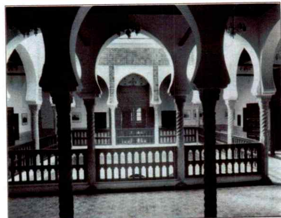
Fig. 2.3 Habitat traditionnel (Casbah d'Alger) Src : PETRUCCIOLI. A, « Alger 1830-1930. Pour une lecture typologique des immeubles d'habitation ».
