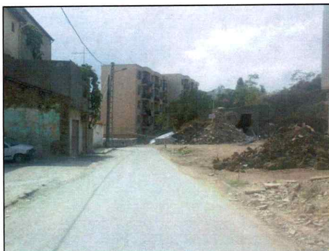
Fig.3.39- Vue sur le côté sud du site.
