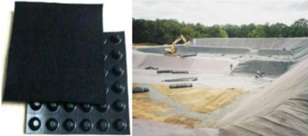
Figure III. 8: Géo-membrane à gauche leur forme, et à droite leur mise en place [7].
