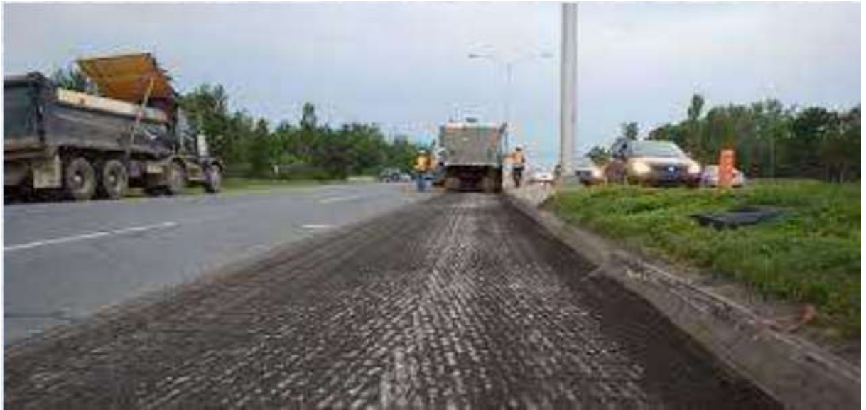
Figure I. 38: Dé-Cohésionnement/stabilisation.
