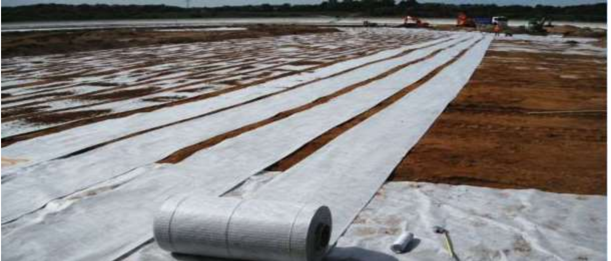
Figure I. 39: Application des nappes géo-synthétiques.
