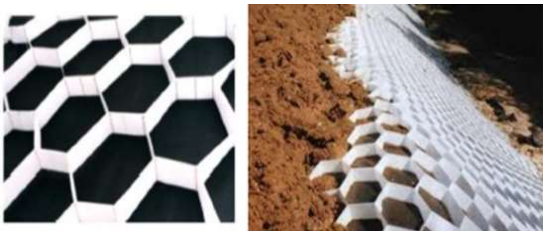
Figure III. 9: à gauche la forme d'un géo-synthétique alvéolaire, à droite placement d'une nappe [7].
