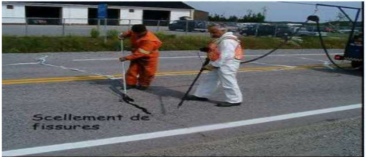
Figure I. 34: Scellement de fissures.
