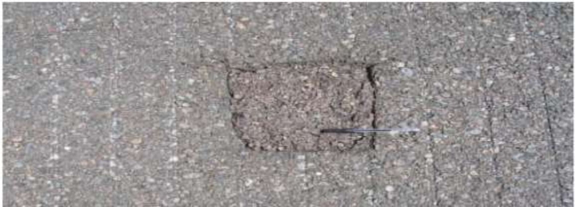
Figure I. 31: Réparation ponctuelle [2].
