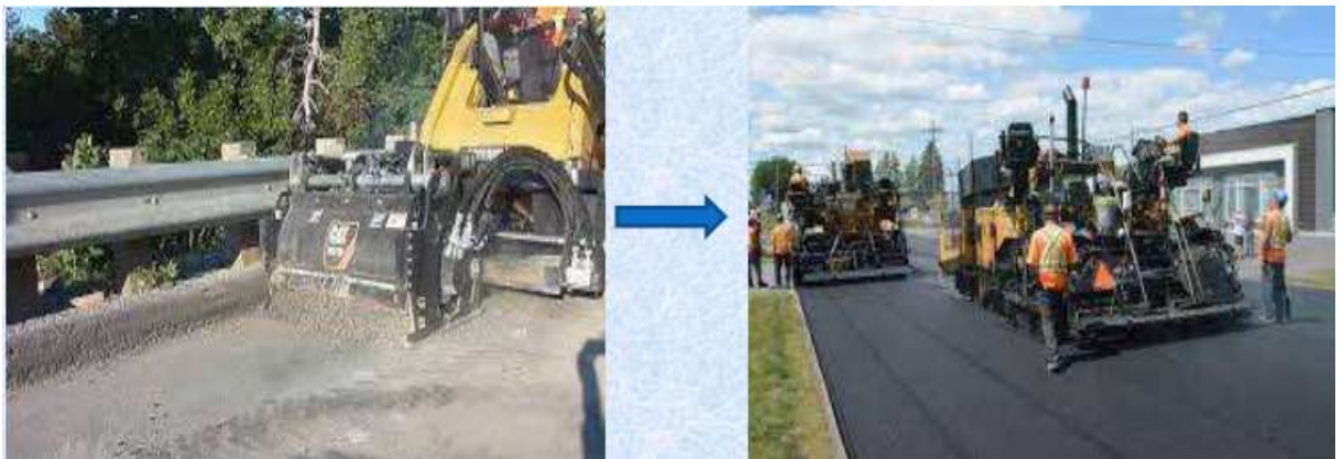
Figure I. 35: Le planage et l'épandage.
