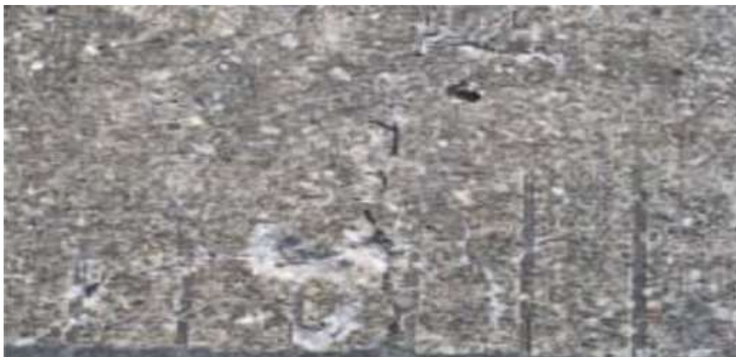
Figure I. 28: Faièncage [2].
