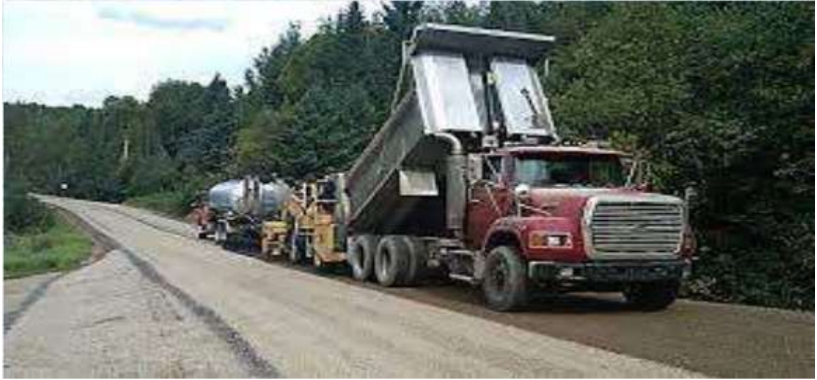
Figure I. 36: Traitement de surface (enduit superficiel).
