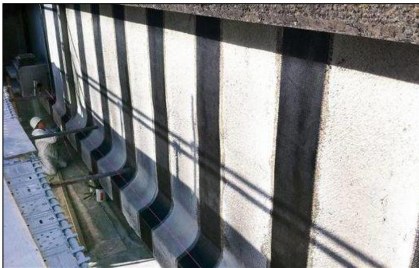
Figure I.33: renforcement par tissu de fibre.
