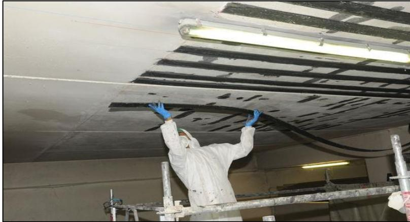
Figure I.31: Renforcement par collage de plats composites.
