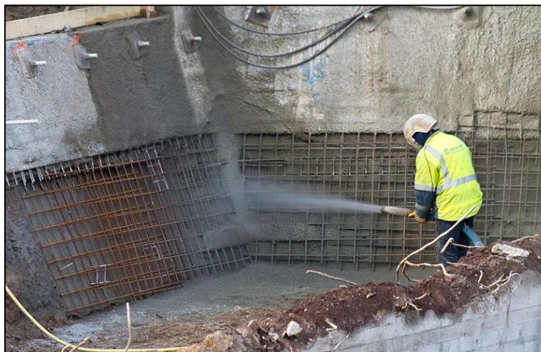
Figure I.32 : projection de béton.
