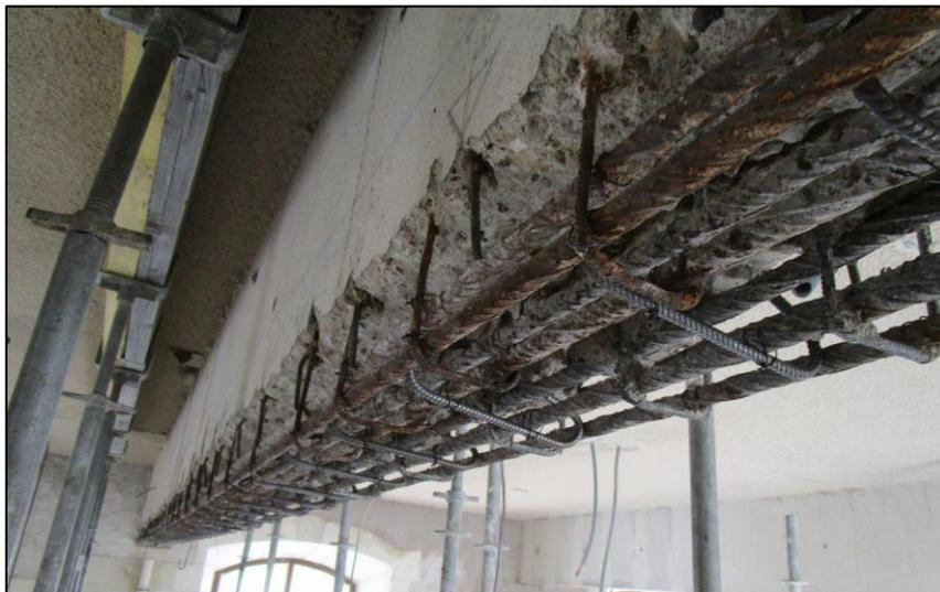
Figure I.30 : Armatures passives additionnelles pour le renforcement d'une poutre.
