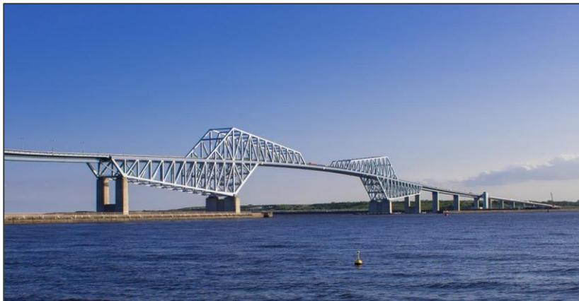
Figure I.21 : pont cantilever.
