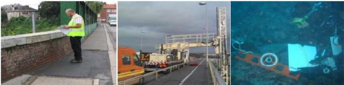
**Figure II.1** : surveillance périodique sans moyens particuliers et inspection détaillée avec nacelle négative visite subaquatique
