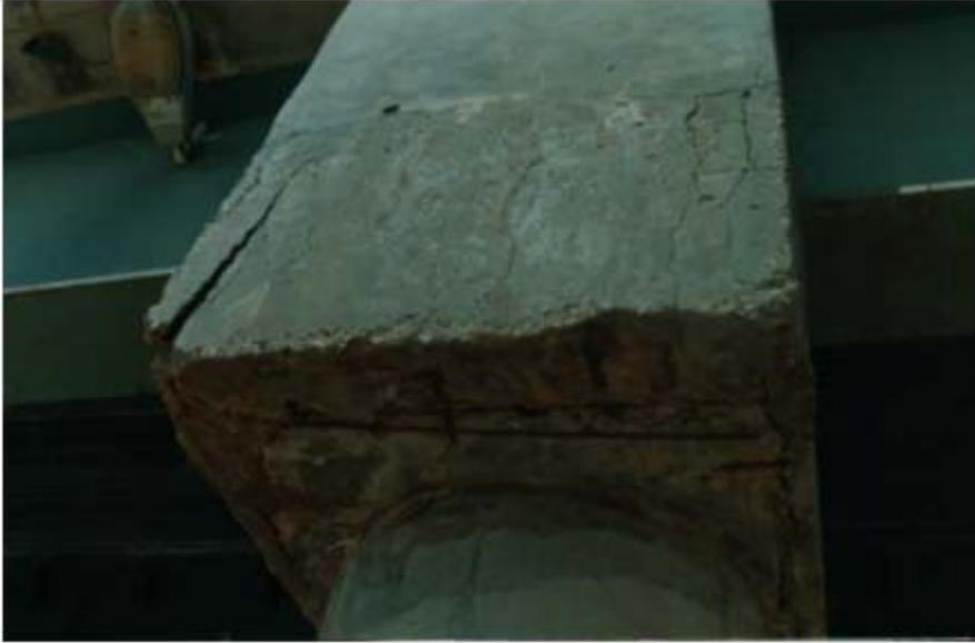
**Figure II.12 :** Les fissures multidirectionnelles localisées aux extrémités du chevêtre
