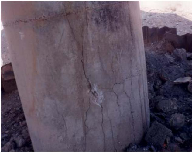
**Figure I.2 : fissure ascendantes dues à la reprise de bétonnage**
