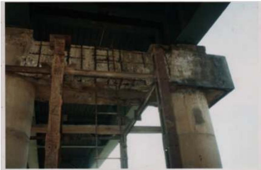
Figure II.11 : Dégradation du chevêtre
