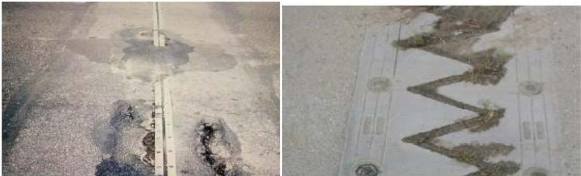
**Figure II.8** : détérioration due au passage des véhicules
