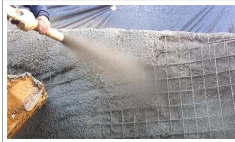
Figure I. 6 Renforcement au moyen de béton projeté
