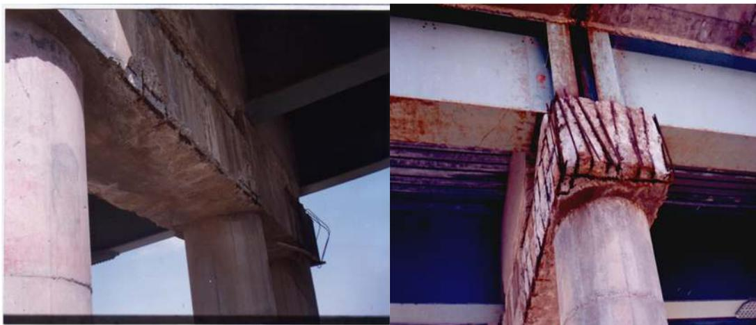
**Figure. I.3 : Traces d'humidité au niveau d'un chevrete** **Figure .I. 4 : corrosion et éclatement du béton**
