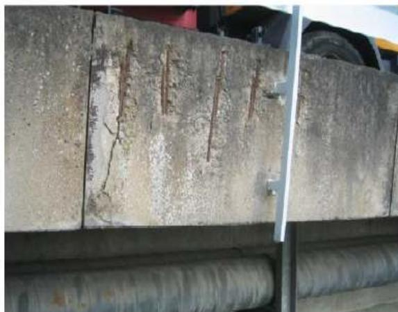
**Figure II.5 :** suite au gel et à l'insuffisance d'enrobage des aciers pour les corniches en BA.
