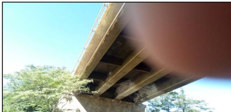
Figure V.2 Dégradations aux niveaux des poutres du pont
