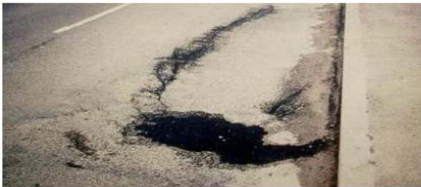
**Figure II.3 :** arrachement localisé du revêtement.
