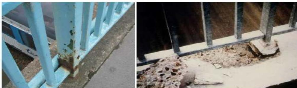
**Figure II.6 :** Fixation défectueuse
