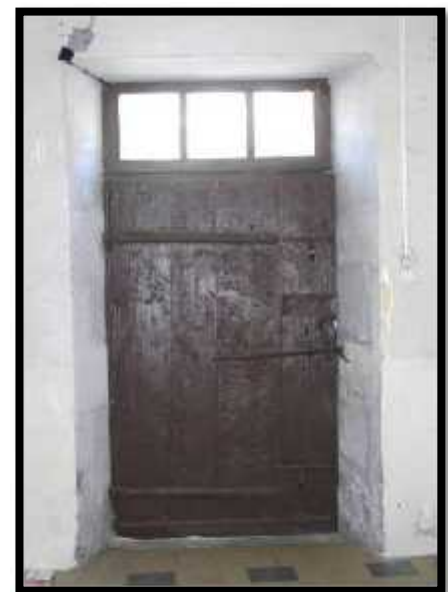
Figure 11 : Linteau droit. Porte en planches clouées contrebalancées. Imposte vitrée.
