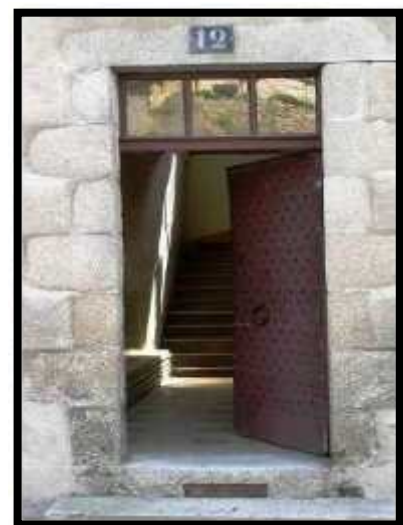
Figure 10 : Linteau en accolade et cavet, Rue Alfred Assolant.
