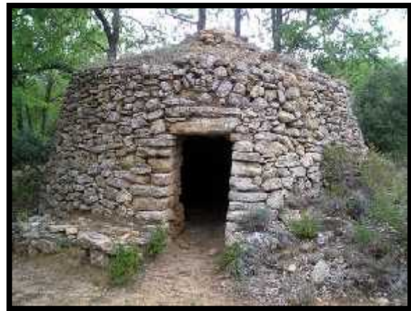
Figure3 : CES CABANES EN PIERRE SÈCHE DE JOUQUES (BOUCHES-DU-RHÔNE)
