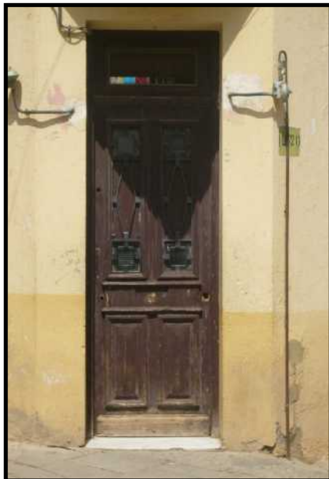
Figure31 : Porte coloniale néoclassique.
