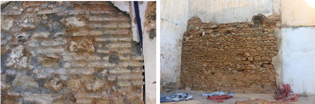
Fig.36, 37_ texture des murs
