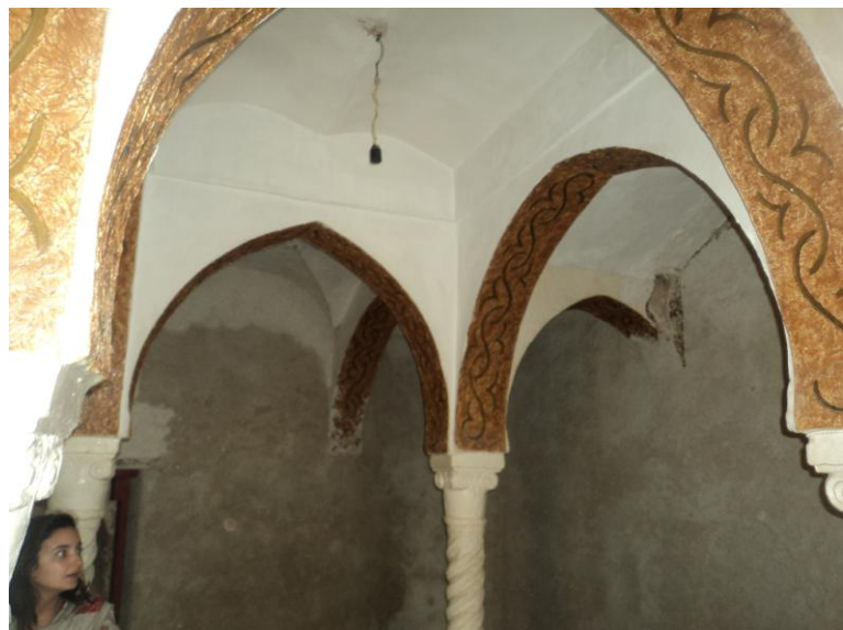
Fig.39_ planché voûtain de l'époque coloniale
