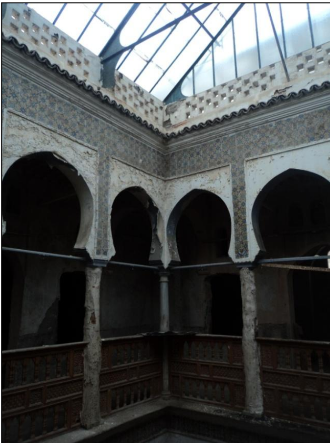
Fig.3_ vue sur le patio
