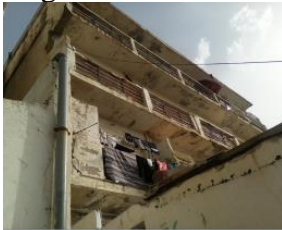
Figure 30 : la façade postérieure des villas ile de France. Source : auteur.
