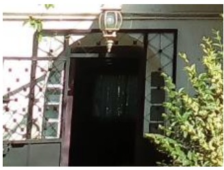
Figure 78 : la porte de la façade postérieure. Source : auteur.
