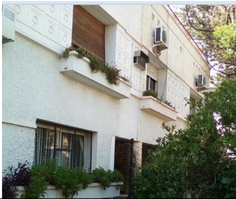
Figure 80 : fenêtre rectangulaire de la façade principale. Source : auteur.
