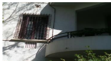
Figure 84 : balcon de la façade postérieure. Source : auteur.
