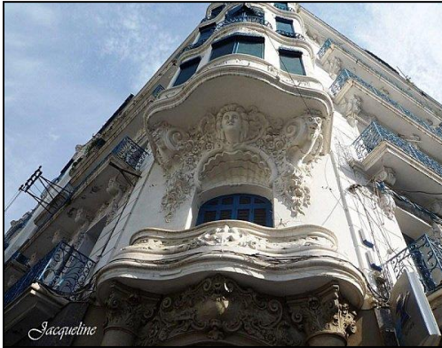
Figure 05 : immeuble urbain à Alger, style art nouveau. Source photos: SSCA section Algiers.
