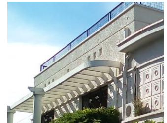
Figure 87 : poutrelles en béton et un garde corps de la terrasse en acier. Source : auteur.
