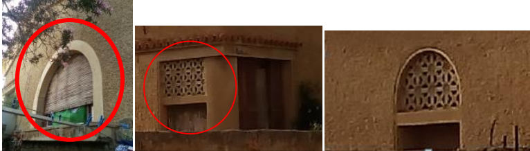
Figure 35 : les fenêtres de la maison. Source : auteur.
