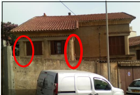
Figure 37 : la façade postérieure de la villa. Source : auteur.
