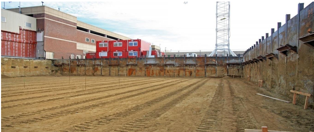
Figure 1.5 : Exemple d'une paroi berlinoise
