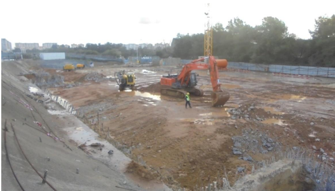
Figure 1.13 : Excavation des terres à l'intérieur du périmètre de la paroi moulée (Site de la station de l'université Houari Boumediene en Algérie)
