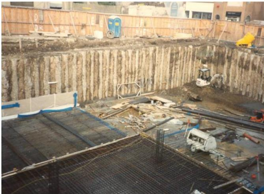
Figure 1.14 : Paroi en pieux sécants
