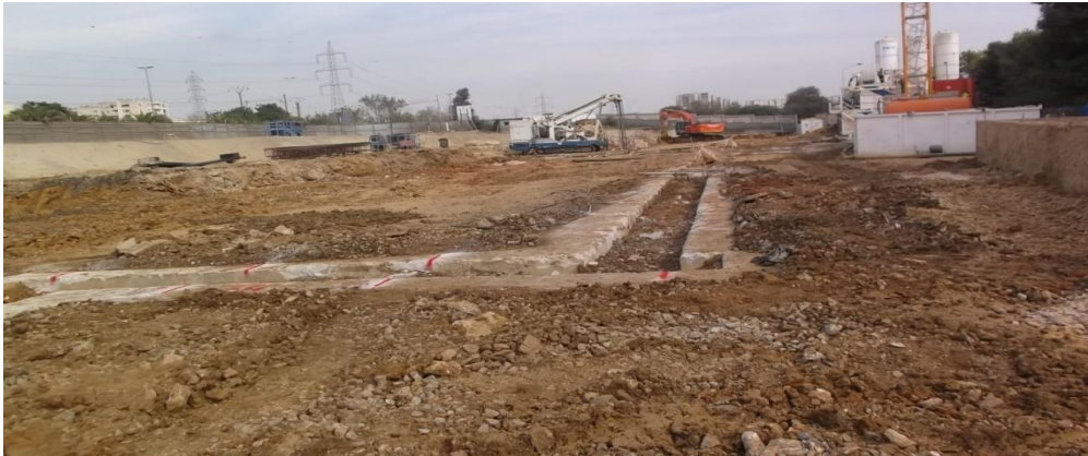
Figure 1.8 : Murette guide d'une paroi moulée
