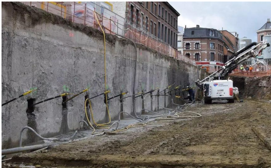
Figure 1.16 : Exemple d'une paroi avec tirants d'ancrage
