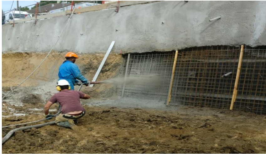
Figure 1.3 : Projection du béton sur une paroi clouée
