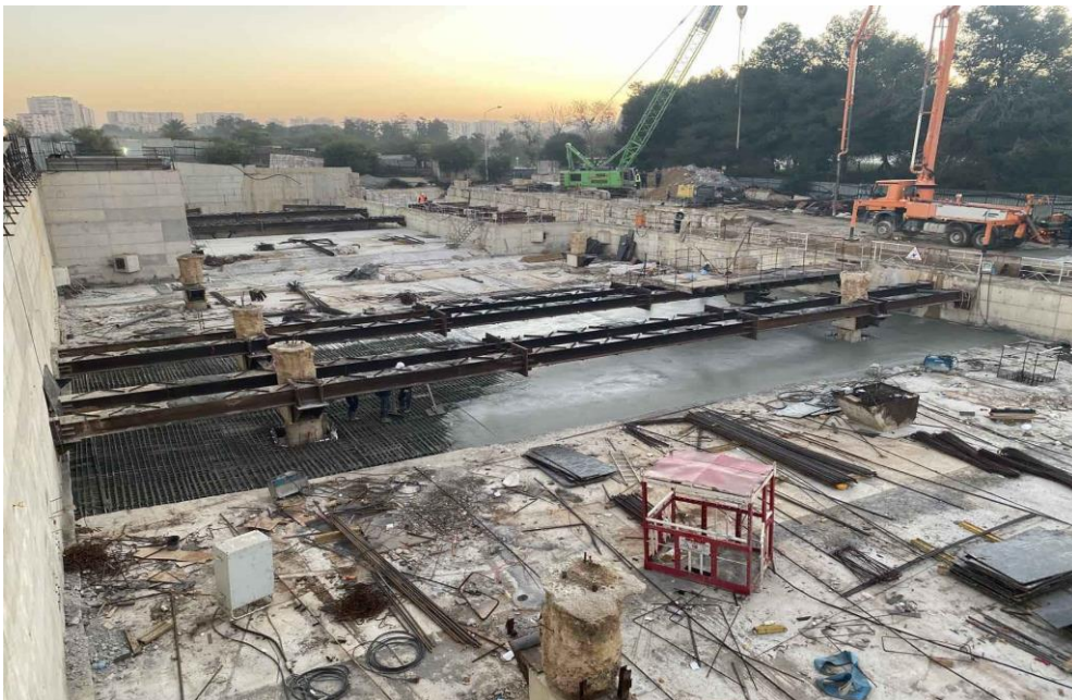
Figure 1.15 : Exemple de butons (Site de la station de l'université Houari Boumediene en Algerie)
