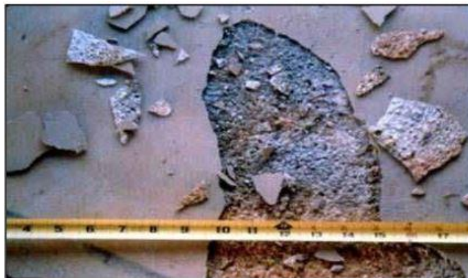
Figure VII. 10 : Délamination d'une dalle Dans[1]
