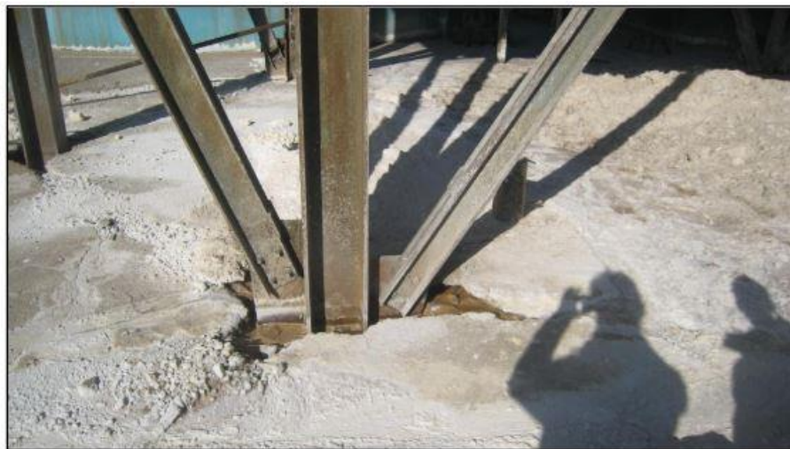
Figure VII. 16 : Tassements d'un fut de fondation [1]
