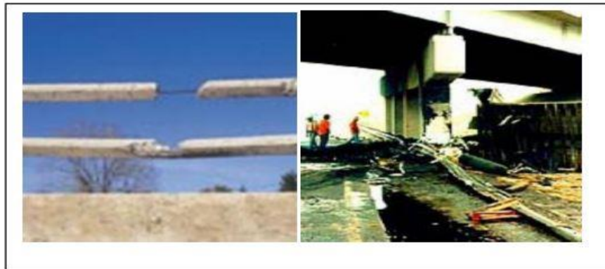
Figure VII. 14 : Choc sur une glissière de sécurité et une pile de pont [1]
