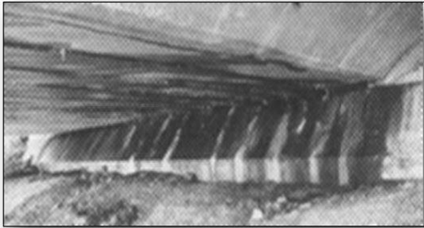
Figure VII. 5 : Contamination par les sels de déglacage. [1]
