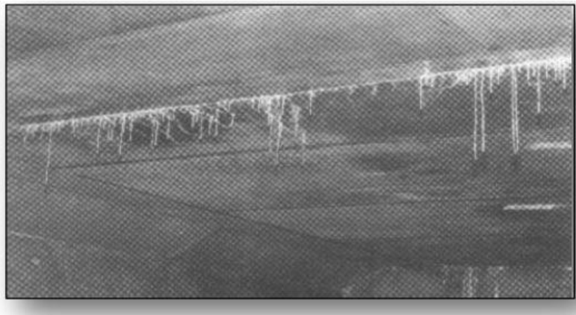
Figure VII. 6 : Pénétration des chlorures dans une poutre caisson. [1]
