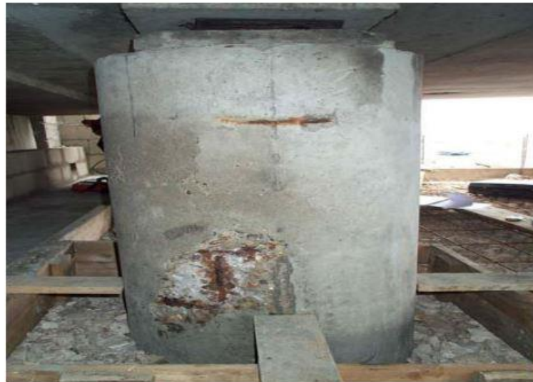
Figure VII. 20 : Pile de pont.
