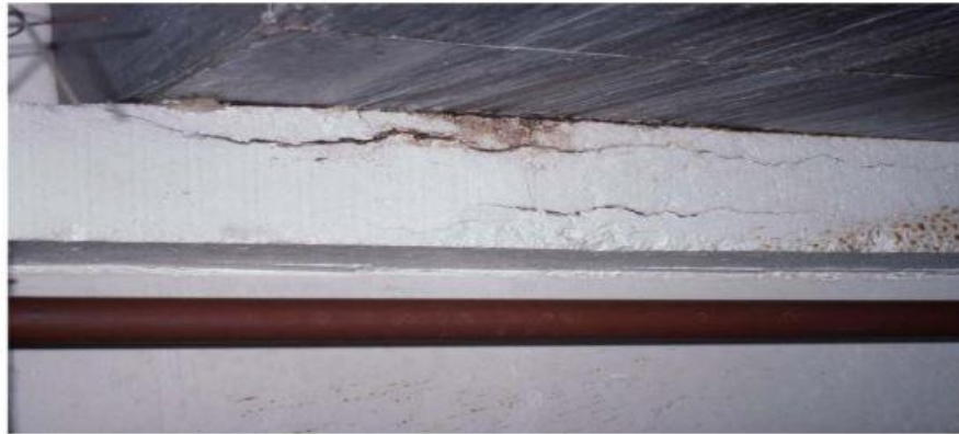
Figure VII. 19 : Poutre support de réservoir
