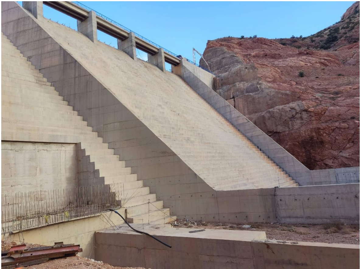
Figure 1.3 Vue aval du barrage
