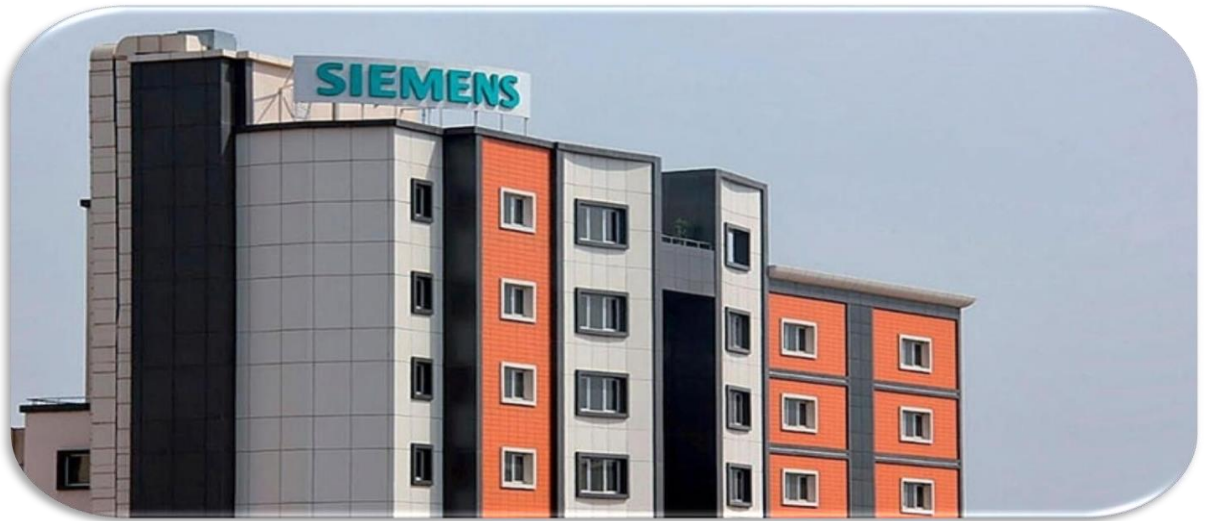
Figure 1.1 Siège de SIEMENS en Algérie.
