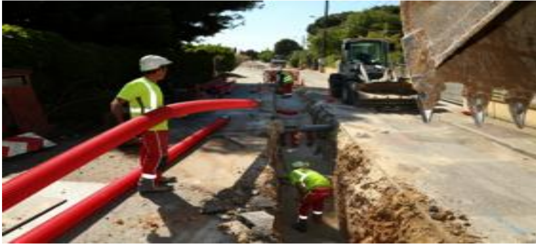
Figure 1-3 Un réseau souterrain.
