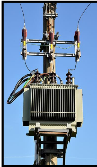
Figure2.8 : Transformateur de tension.
