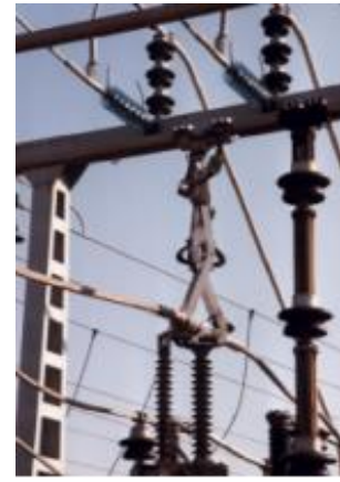
Figure2.14 : Sectionneur pantographe
