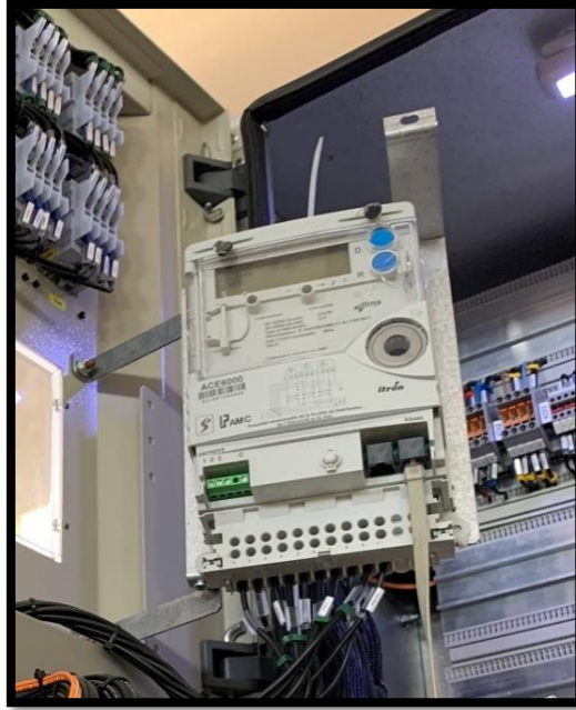
Figure 2.4 : Compteur électrique.
