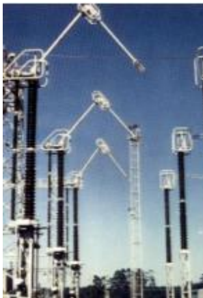
Figure2.12 : Sectionneur horizontal
