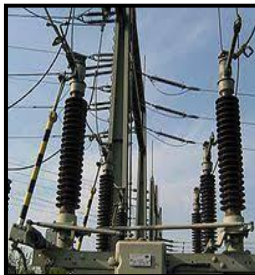
Figure2.10 : Sectionneur de barre.
