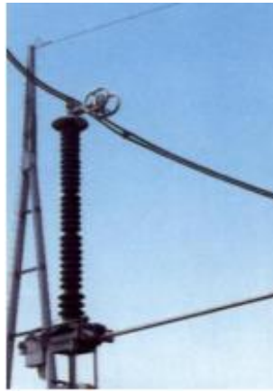
Figure2.13 : Sectionneur vertical
