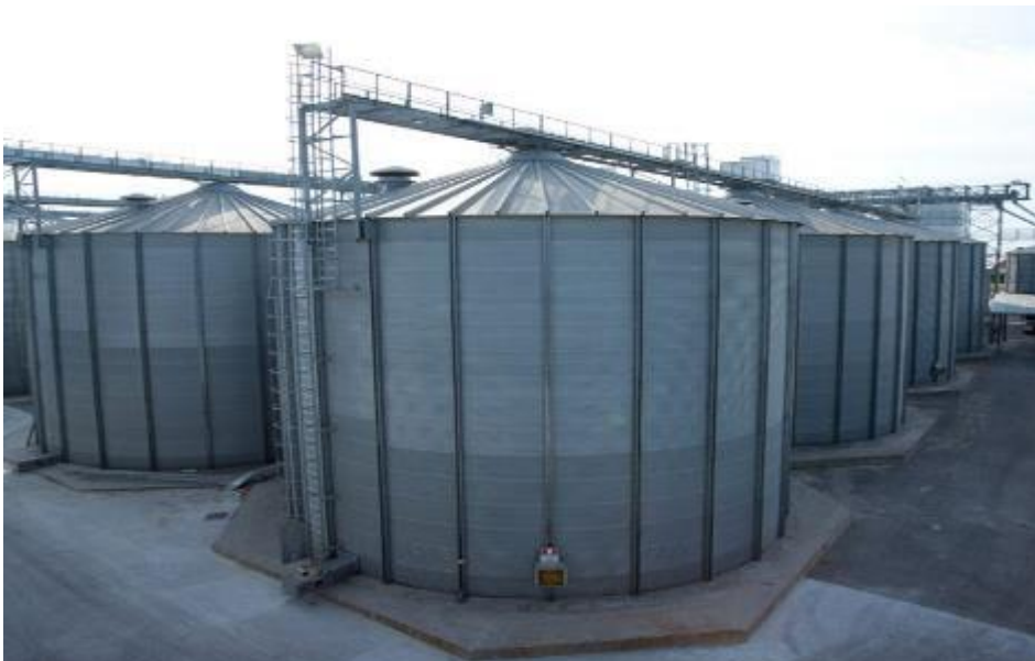
Figure1.2. Les silos de stockage matières premières
