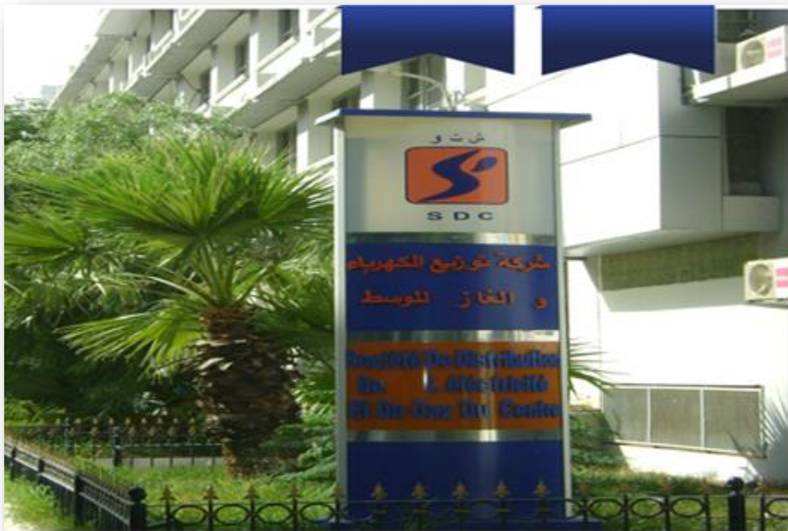
Figure I.2. La direction de Distribution de l'électricité et du gaz du Centre (RDC).
