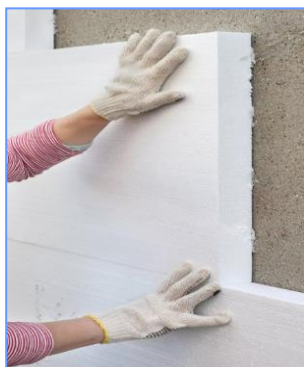
Figure II-7 : la pose des panneaux en polystyrène (29)
