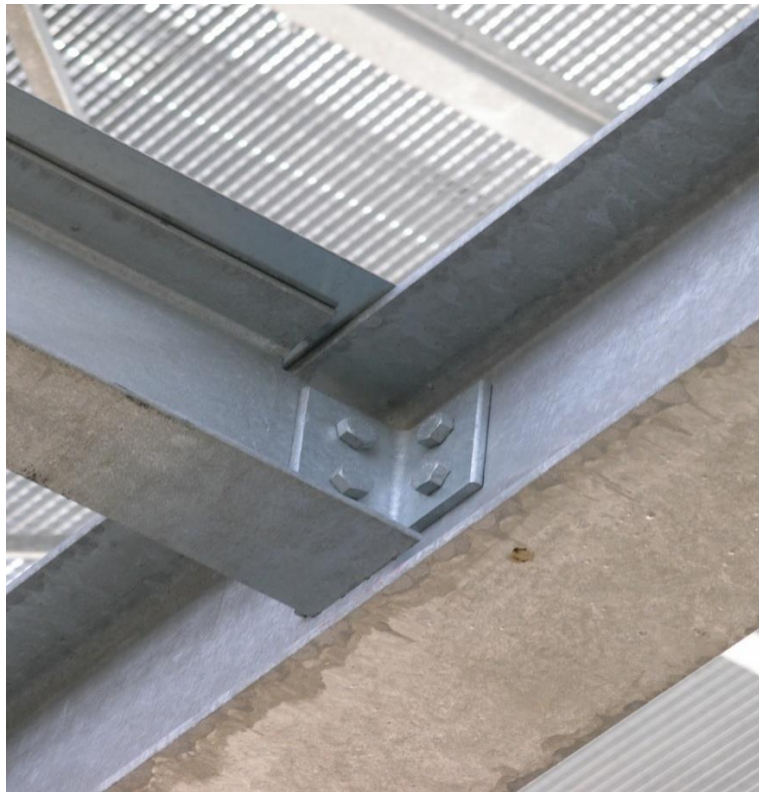
Figure VI.3 : Modèle d'Assemblage poutre-solive.
