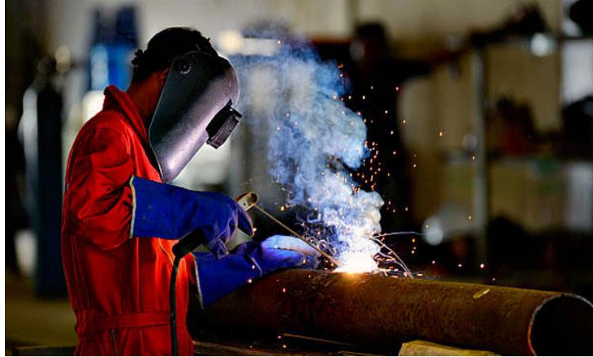
Figure I.6 : Le soudage en charpente métallique
