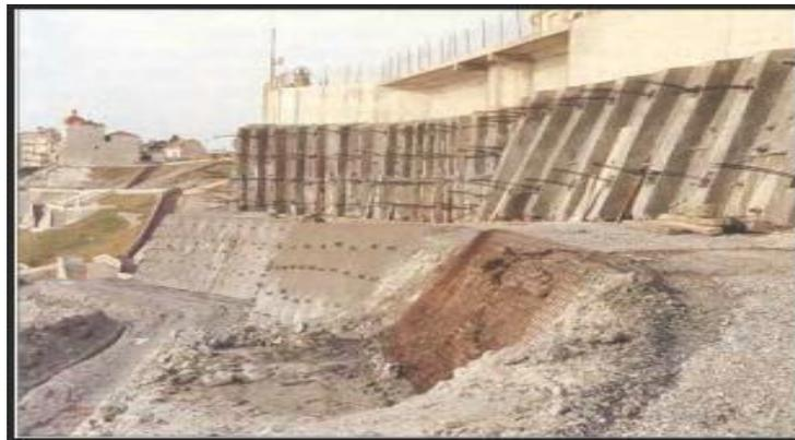
**Figure 1.34** Schéma de confortation par tirants d'ancrages.
