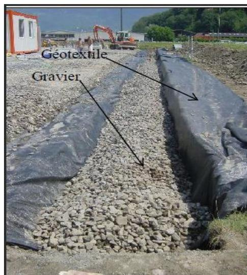
**Figure 1.27:** Coupe type d'une tranchée drainante
