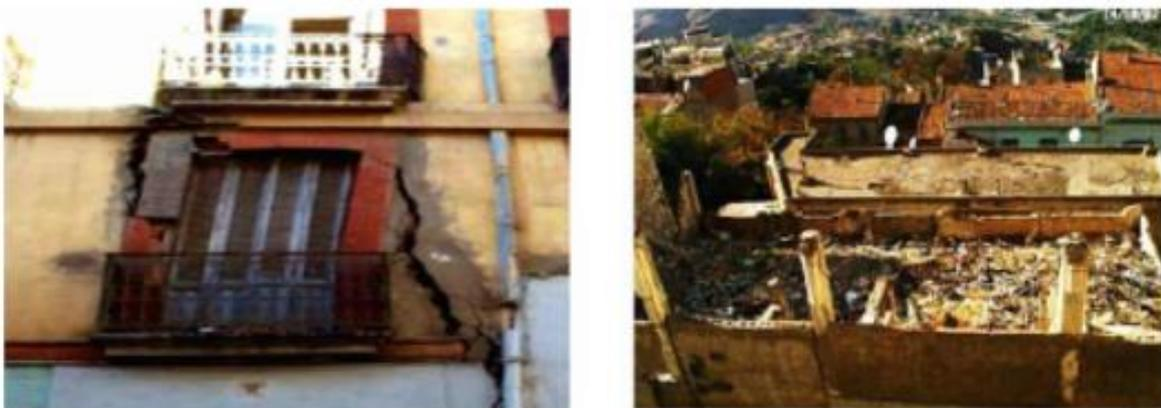
**Figure 1.12:** Fissures causées par le Glissement de terrain à Belouizdad. 2002
