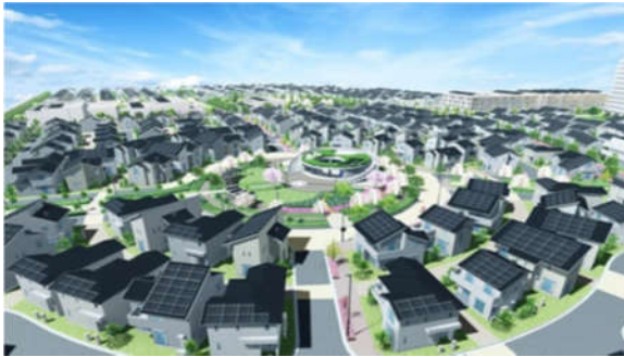
Fig. 36 : Toit avec panneaux photovoltaïques
