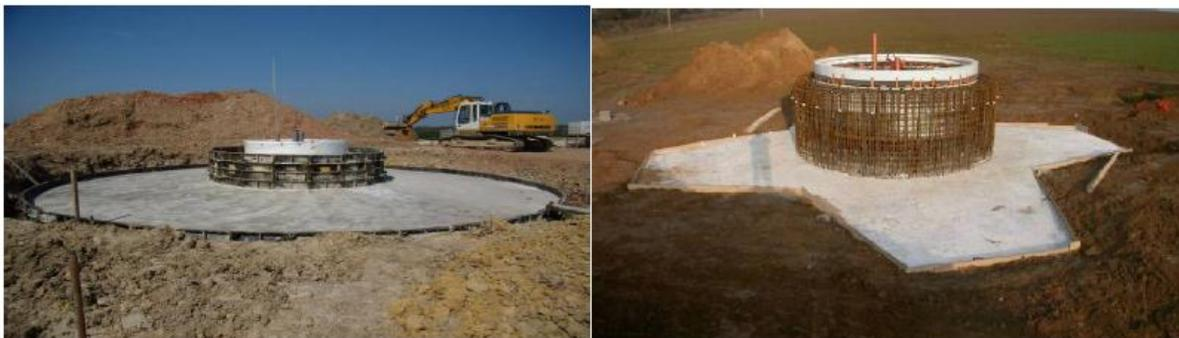
Figure (I.20). La fondation en béton
