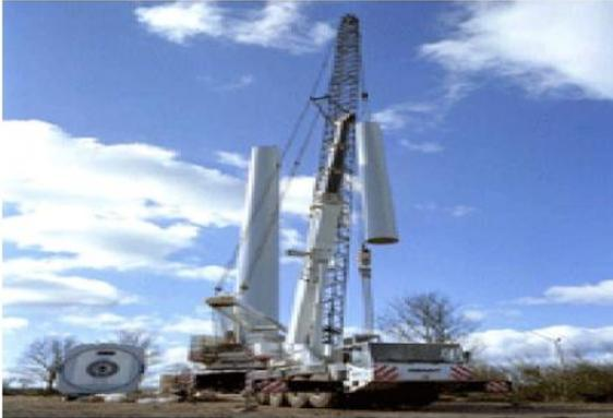
Figure (I.8). Montage d'un mât tubulaire
