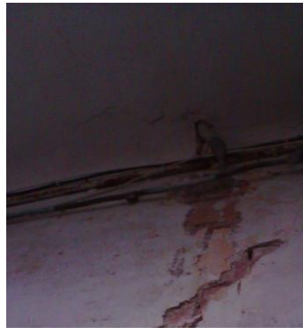
Fig.26. Mur en brique, source, Auteur
