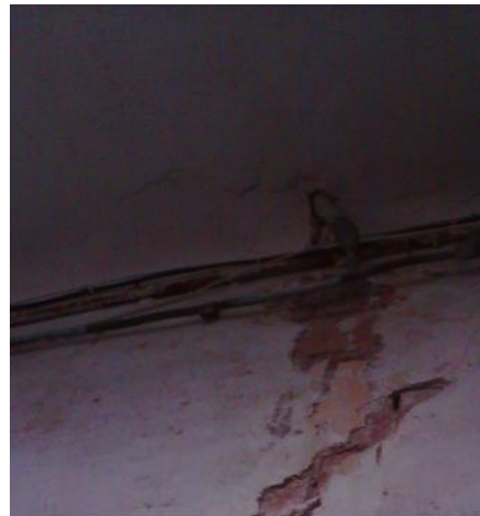
Fig.26. Mur en brique, source, Auteur
