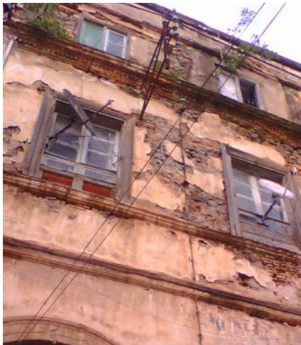
Fig.25. Façade en moellons, source, Auteur
