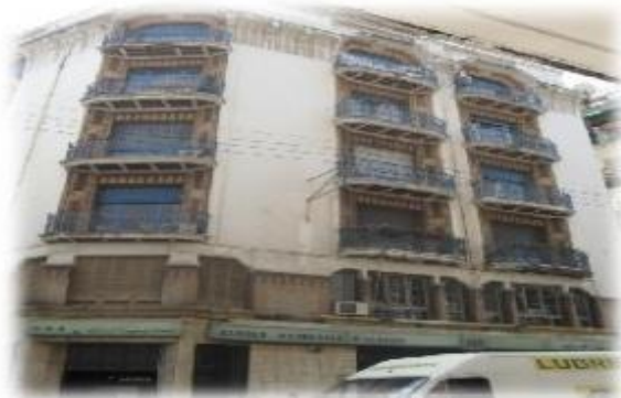
Fig.15. Façade immeuble 45 rue Didouche Mourad. Du style art déco à Alger.
