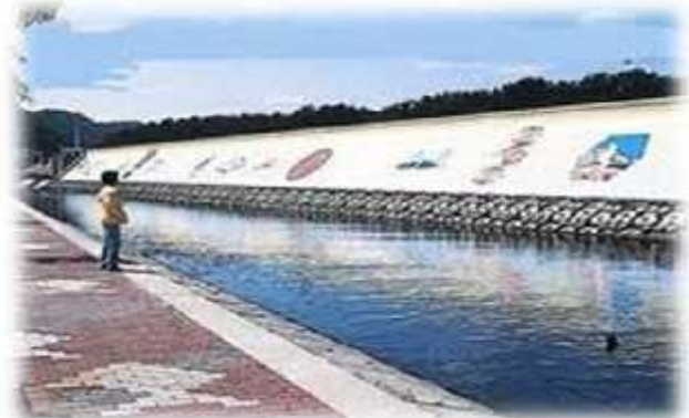
1. A Taro, au Japon, le mur Anti-tsunamis n'a pas pu faire face à la puissance de celui-ci. L'eau a de plus été bloquée à l'intérieur des terres, le mur l'empêchant de se retirer.
