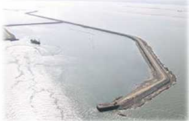
2. Un brise-lames présenté sous forme de digue au large d'une côte japonaise
