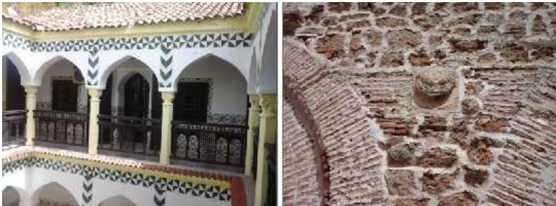
Fig. 2. 15 _ Décor de céramique du patio de la maison et de pierre sur la façade principale avec une petite sculpture datant de la première construction. Photo prise par l'auteur en août 2015.
