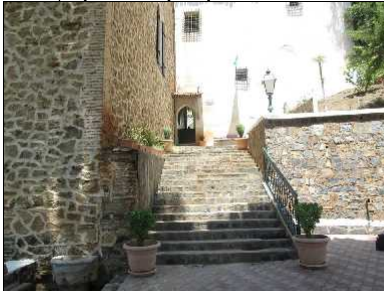
Fig.2. 10 _ escalier menant vers la porte d'entrée de la maison revêtement en pierre. Photo prise par l'auteur en aout 2015.
