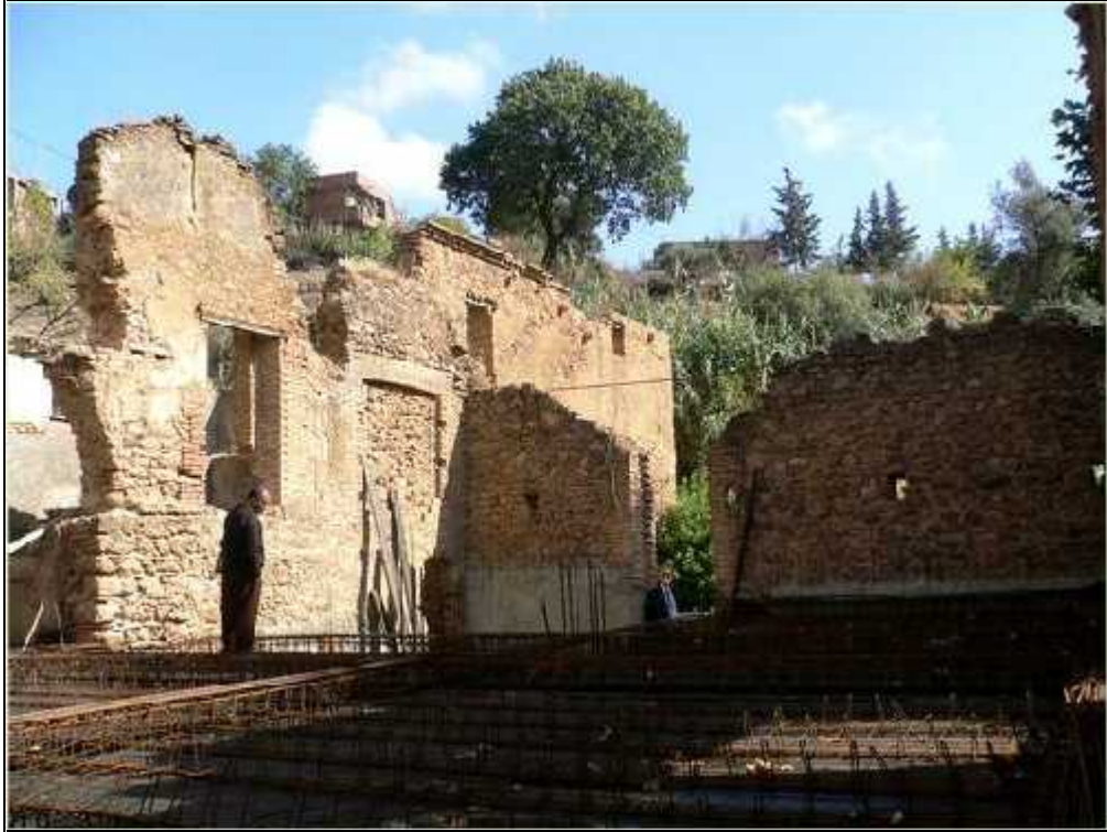
Fig.2. 28 _ Vue lors du commencement des travaux de restauration. Photo crédit www.algeriemiliana.com .
