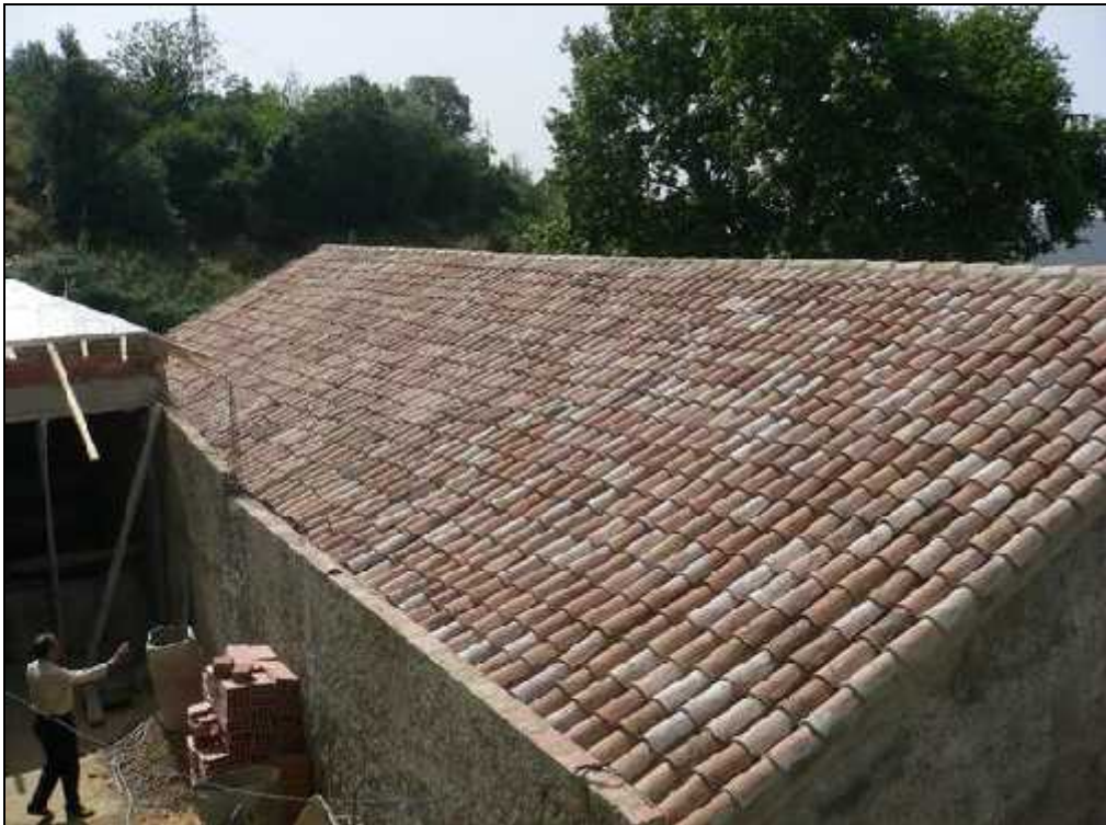
Fig.2 .33 _ vue sur la toiture de l'annexe lors des travaux de restauration. Photo crédit algeriemiliana.com .
