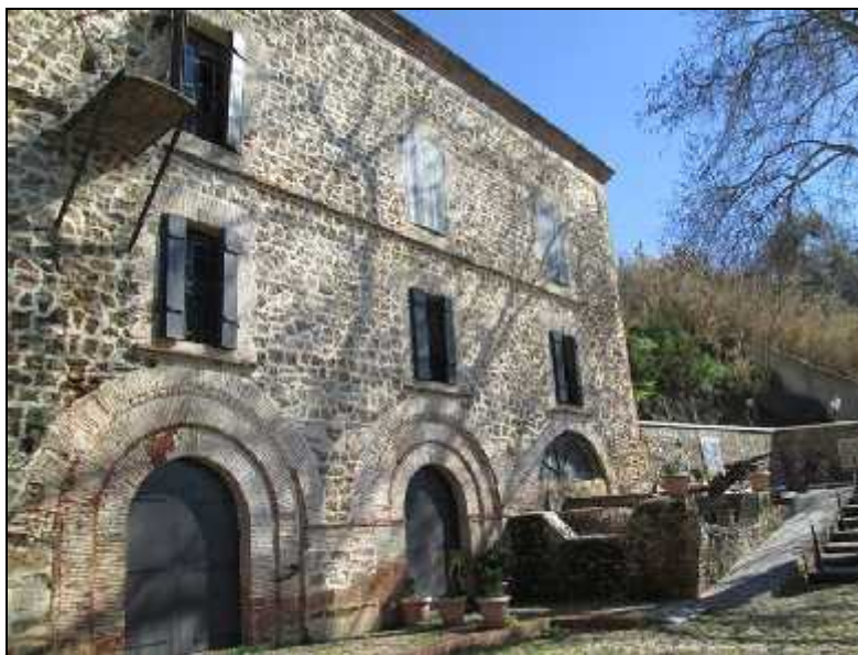
Fig.2. 5 _ vue sur la façade principale de l'atelier. Photo prise par l'auteur en aout 2015.
