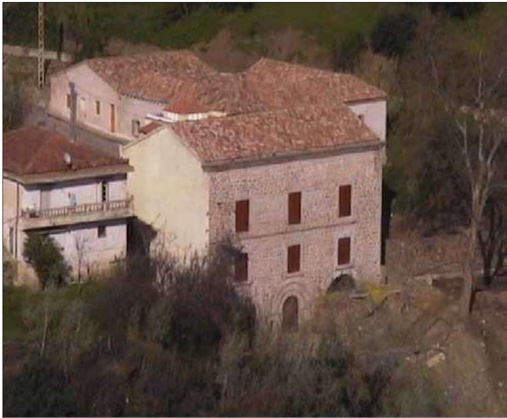
Fig1.4-Vue d'Ensemble de la Manufacture d'armes après restauration. Photo crédit Akli Ahmed.
