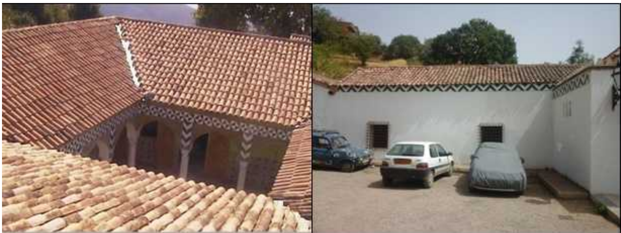
Fig.2.9 _ vue sur la toiture de la maison. Photo prise par l'auteur en aout 2015.
