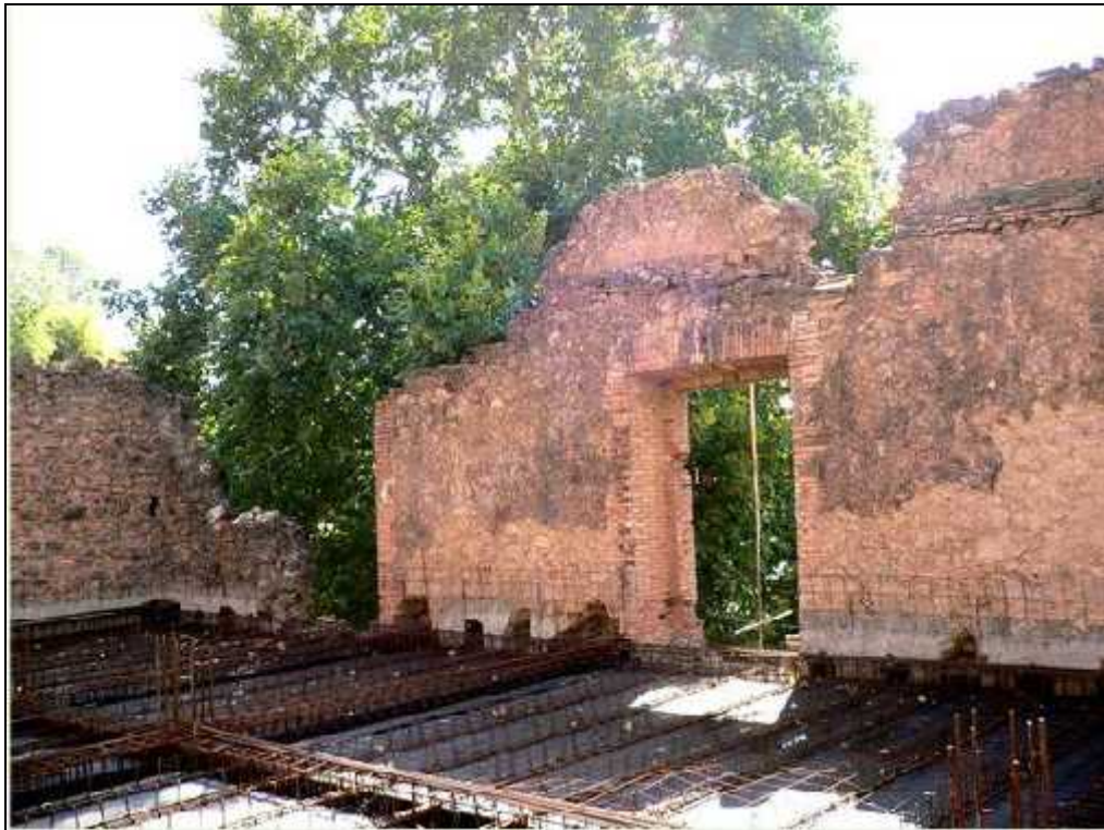
Fig.2. 29 _ Vue lors du commencement des travaux de restauration. Photo crédit www.algeriemiliana.com .
