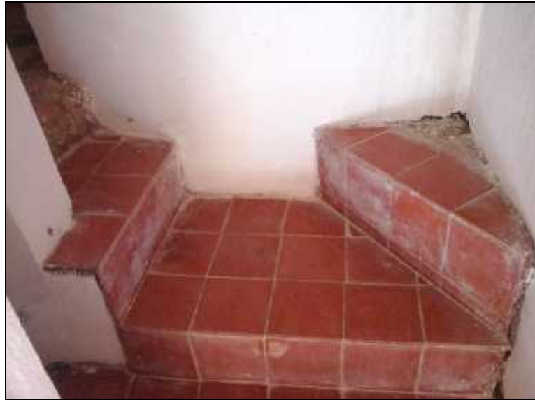
Fig.2. 12 _ escalier du hammam revêtement en carrelage. Photo prise par l'auteur en aout 2015.
