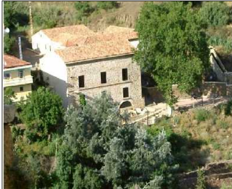
Fig.2. 8 _ vue sur la toiture de l'ancienne manufacture d'armes. Photo : crédit Akli Ahmed.
