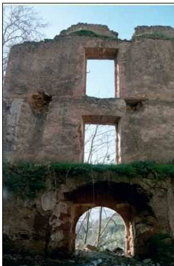
Fig.2 .27 _ Vue d'ensemble de la manufacture d'armes avant restauration. Photo crédit www.algeriemiliana.com .
