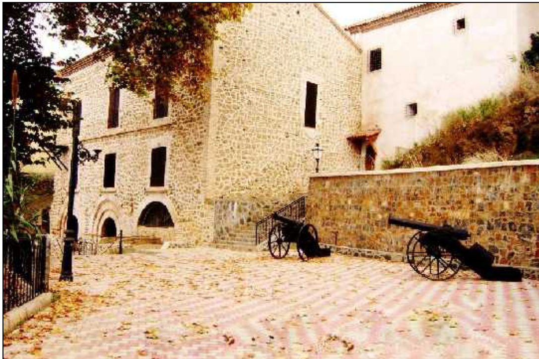
Fig.2.35 _ Vue sur façade latérale de l'Atelier et façade latérale de la maison après Restauration.
