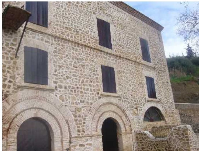
Fig. 2. 3 _ vue sur la façade principale de l'atelier. Photo prise par l'auteur en aout 2015.
