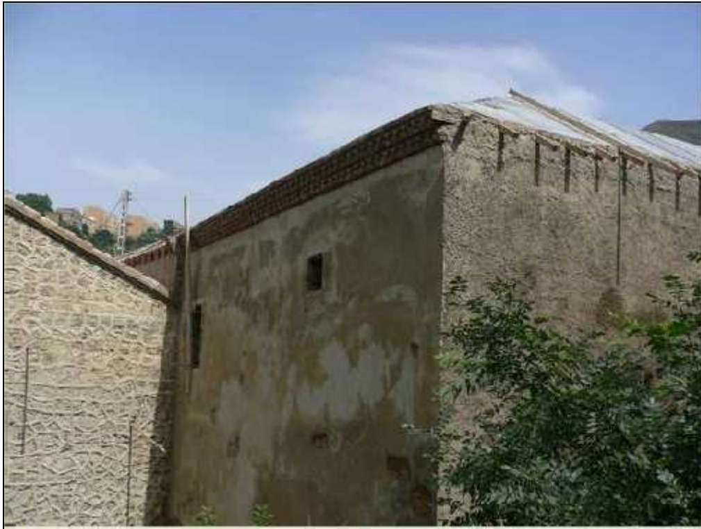
Fig.2. 32 _ Vue sur l'annexe lors des travaux de restauration. Photo crédit www.algeriemiliana.com .
