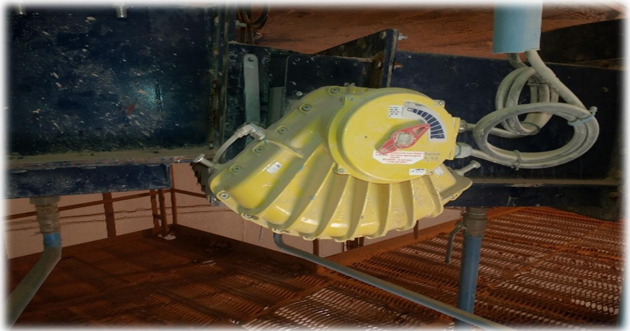
Figure II.2 : la vanne doseuse.
