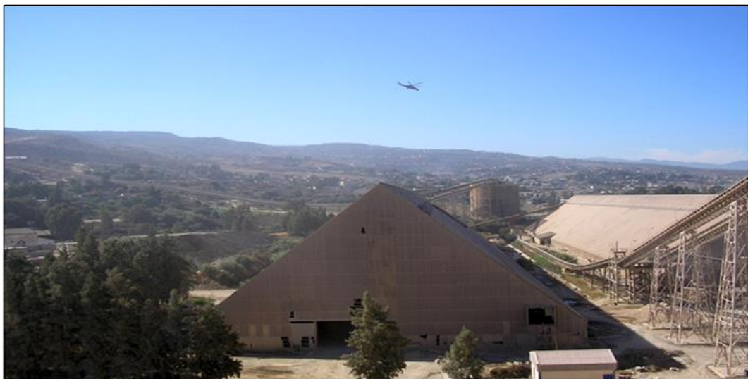
Figure I.4 : Hall de pré homogénéisation.
