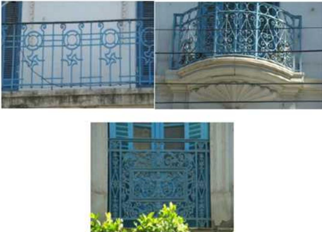
Fig.8: balcon en fer plat fig.9: balconnet en fer forgé fig.10: balconnet en fonte
