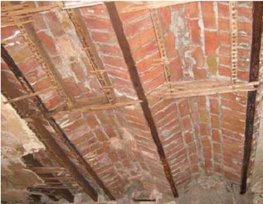
Fig. 13. Plancher à voutain avec brique creuse et faux plafond.
