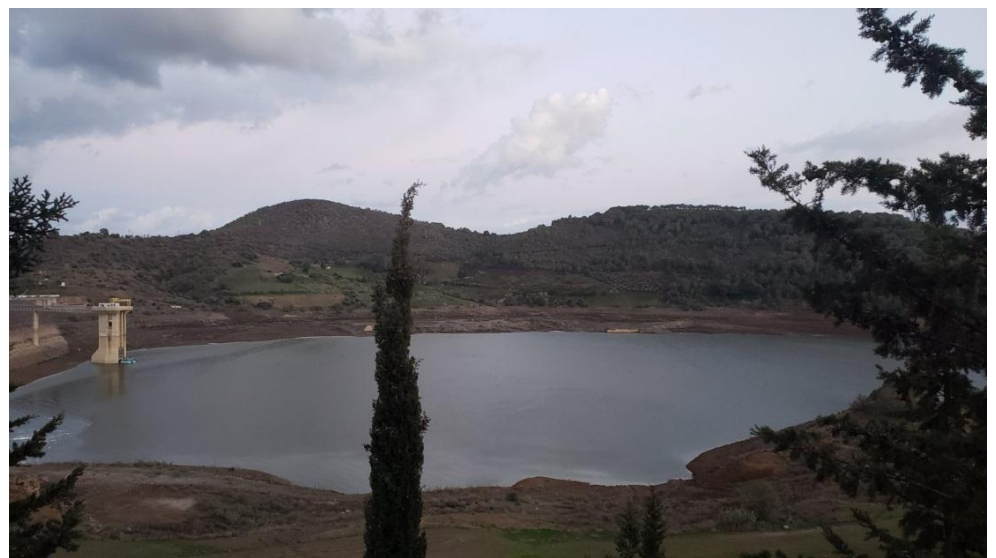
2. Barrage boukerdane en novembre 2021
