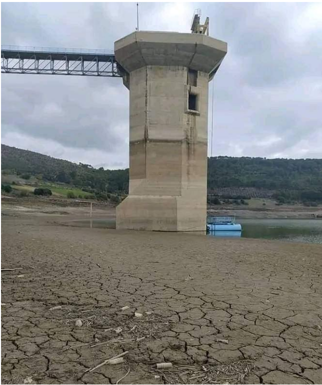
1. Barrage boukerdane juillet 2021
