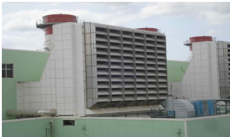
Figure 4: Système d'admission d'air turbine.
