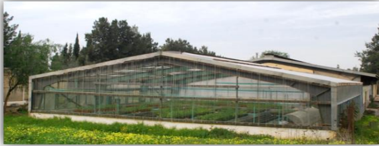
Figure05: vue générale du lieu de l'expérimentation
