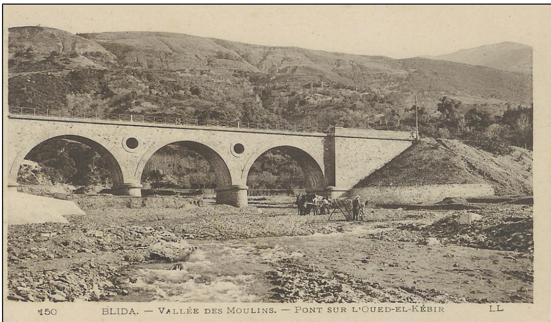
Pont sur l'oued sisi el kebir
