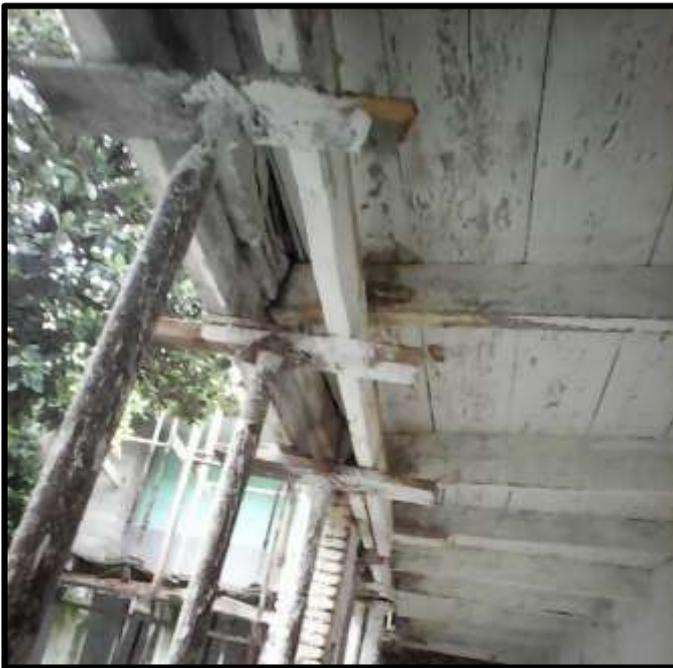
**Figure 158 :** Vue de dessous d'un plancher à solives de bois usiné (Source : Bouhennache Taqiyeddine)
