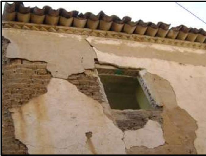
**Figure 224 :** Une corniche en saillie constituée d'une double rangé de brique de terre cuite dont l'une des deux incline les briques à 45 degré (Source : Bouhennache Taqiyeddine)
