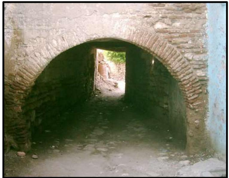
**Figure 207 :** Un arc en brique de terre cuite en plein cintre pour support d'un « Sabat » (Source : Inconnue)
