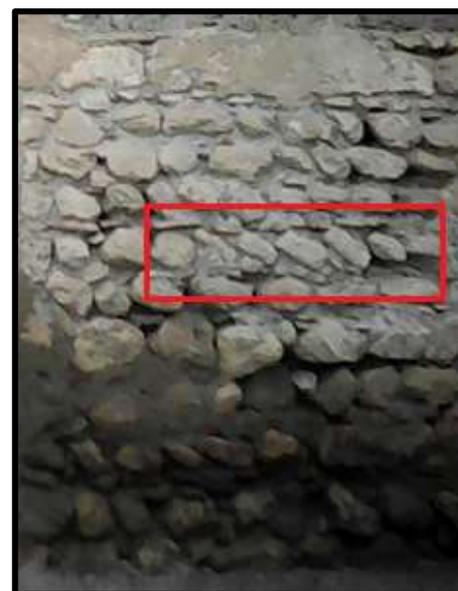
**Figure 135 :** Photos illustrent l'utilisation d'appareillage en EPI traditionnel au centre historique de Mila (Source : Bouhennache Taqiyeddine)
