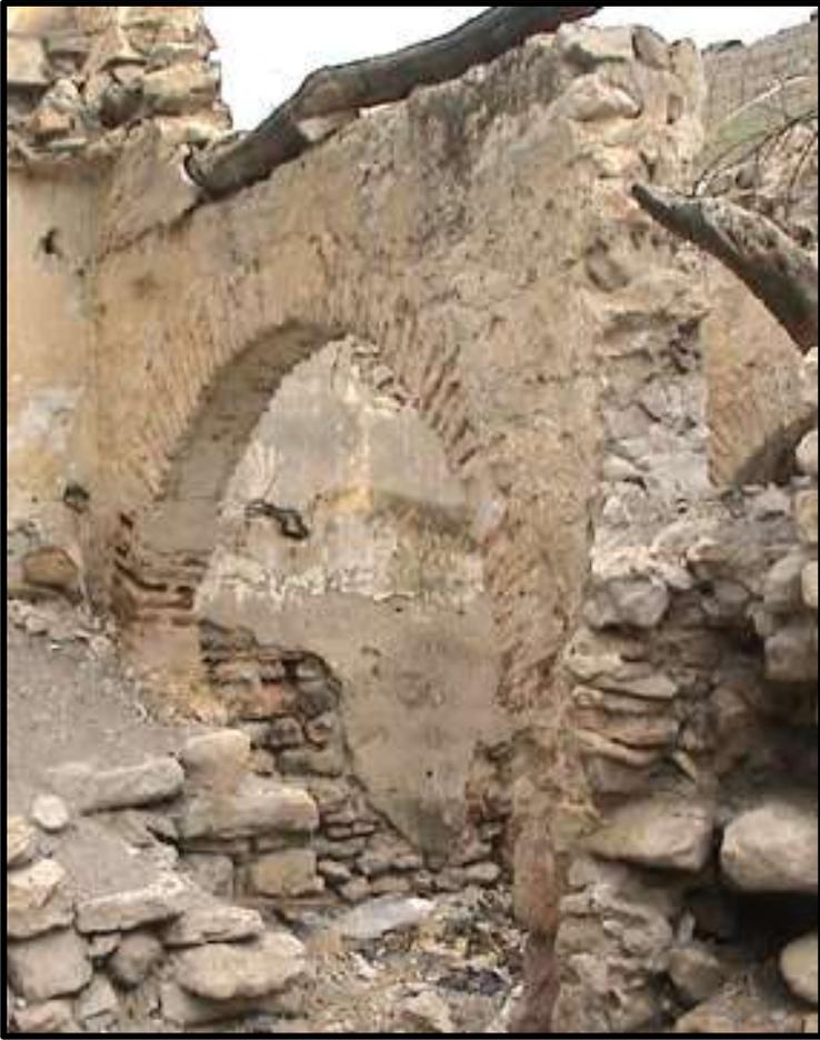
**Figure 204 :** Un arc en brique de terre cuite en plein cintre pour support d'un « Sabat » (Source : Inconnue)
