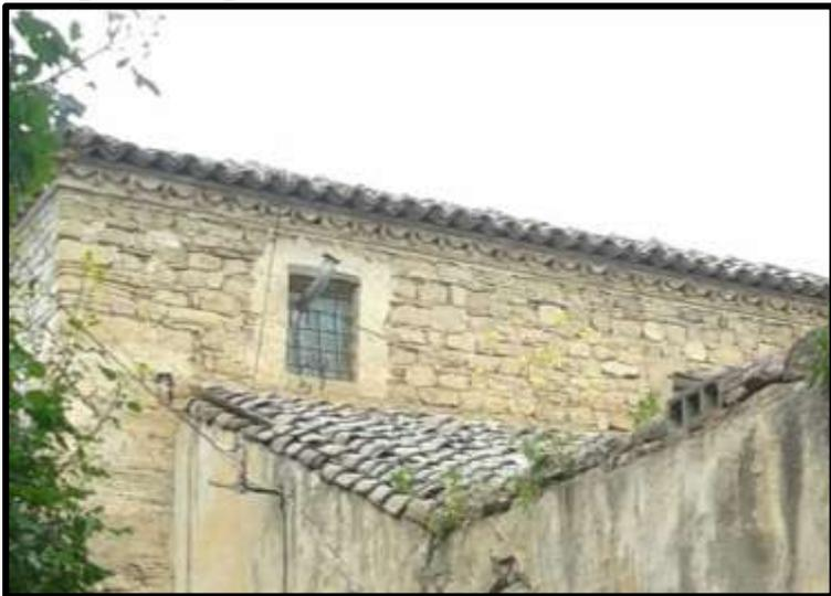
**Figure 225 :** Une corniche en saillie constituée d'une rangé de tuile canal, dont entre chaque deux tuiles une brique de terre cuite est mise perpendiculairement, prise en sandwich entre deux rangés de brique de terre cuite (Source : Bouhennache Taqiyeddine)
