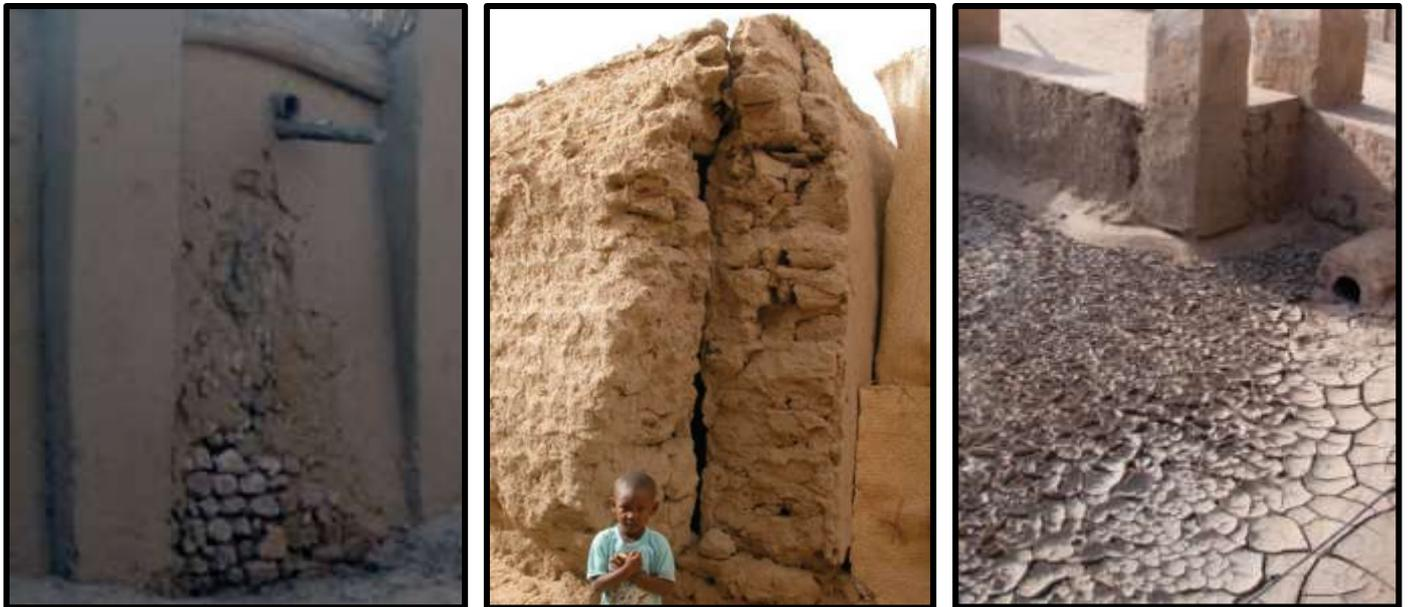
**Figure 64 :** dégradations de différents degrés dues aux plusieurs facteurs (Source : *Manuel pour la conservation de Tombouctou*)
