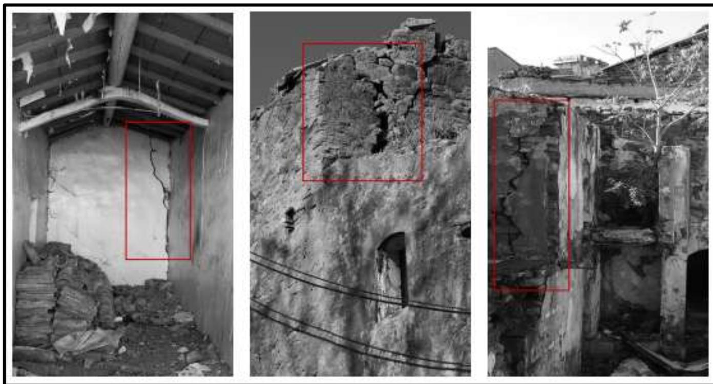
**Figure 43 :** images représentent des murs endommagés (Source : Manuel de réhabilitation pour la ville de Dellys)
