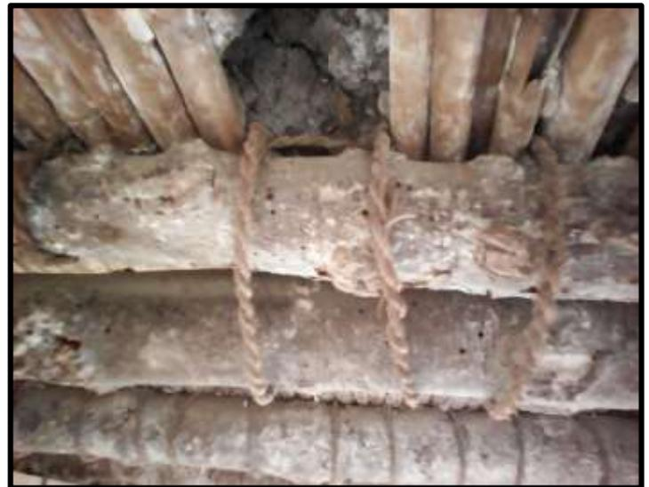
**Figure 157 :** L'utilisation des fils artisanaux pour créer une liaison entre les différents composants de plancher (Source : Bouhennache Taqiyeddine)
