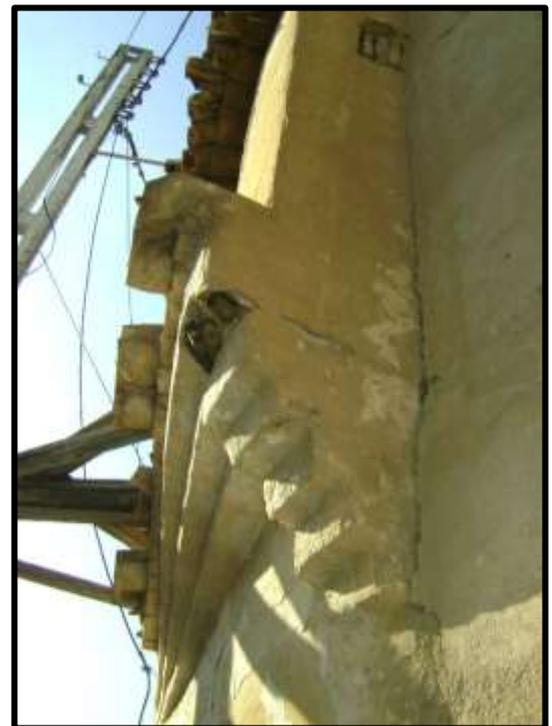
**Figure 178 :** A droite on voit un qbou avec un système constructif en gradins sur un seul côté (Source : Bouhennache Taqiyeddine)
