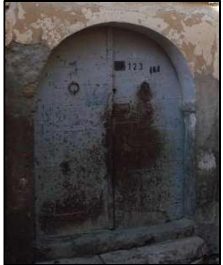
**Figure 209 :** Une porte d'entrée d'une maison au centre historique de Mila sous forme d'un arc en plein cintre en brique de terre cuite (Source : Inconnue)
