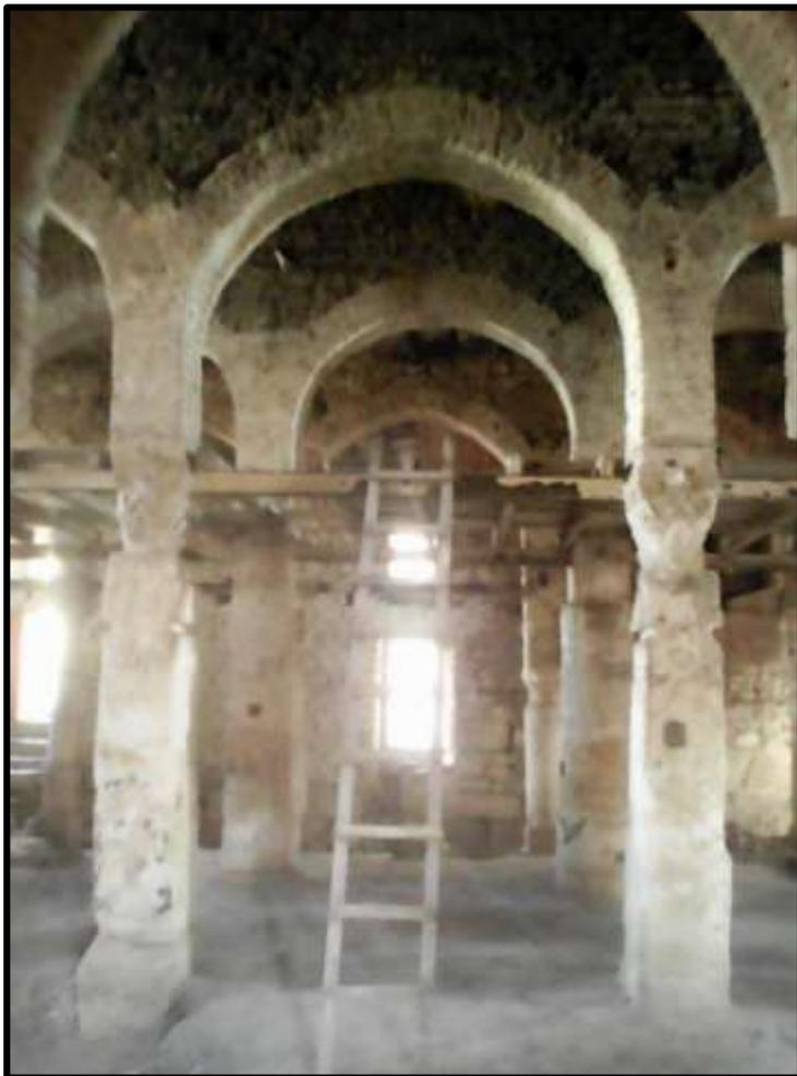
Figure 201 : Des arcades en ogive en brique de terre cuite pour supporter la toiture de la mosquée Sidi Ghanem (Source : Bouhennache Taqiyeddine)
