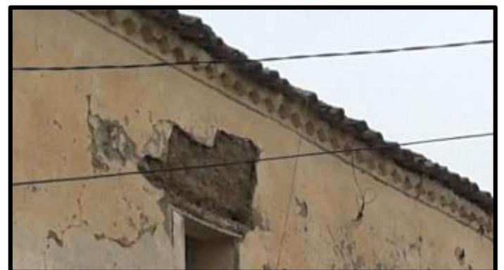
**Figure 223 :** Une corniche en saillie constituée d'une rangé de tuile canal prise en sandwich entre deux rangés de brique de terre cuite (Source : Bouhennache Taqiyeddine)
