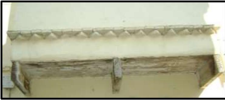
**Figure 172 :** Les assises en briques qui marquent le niveau de plancher de qbou (Source : Bouhennache Taqiyeddine)
