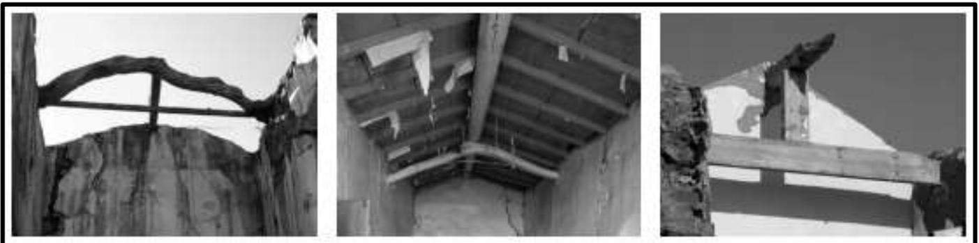
**Figure 35 :** images représentent les différents types de couvertures (Source : Manuel de réhabilitation pour la ville de Dellys)
