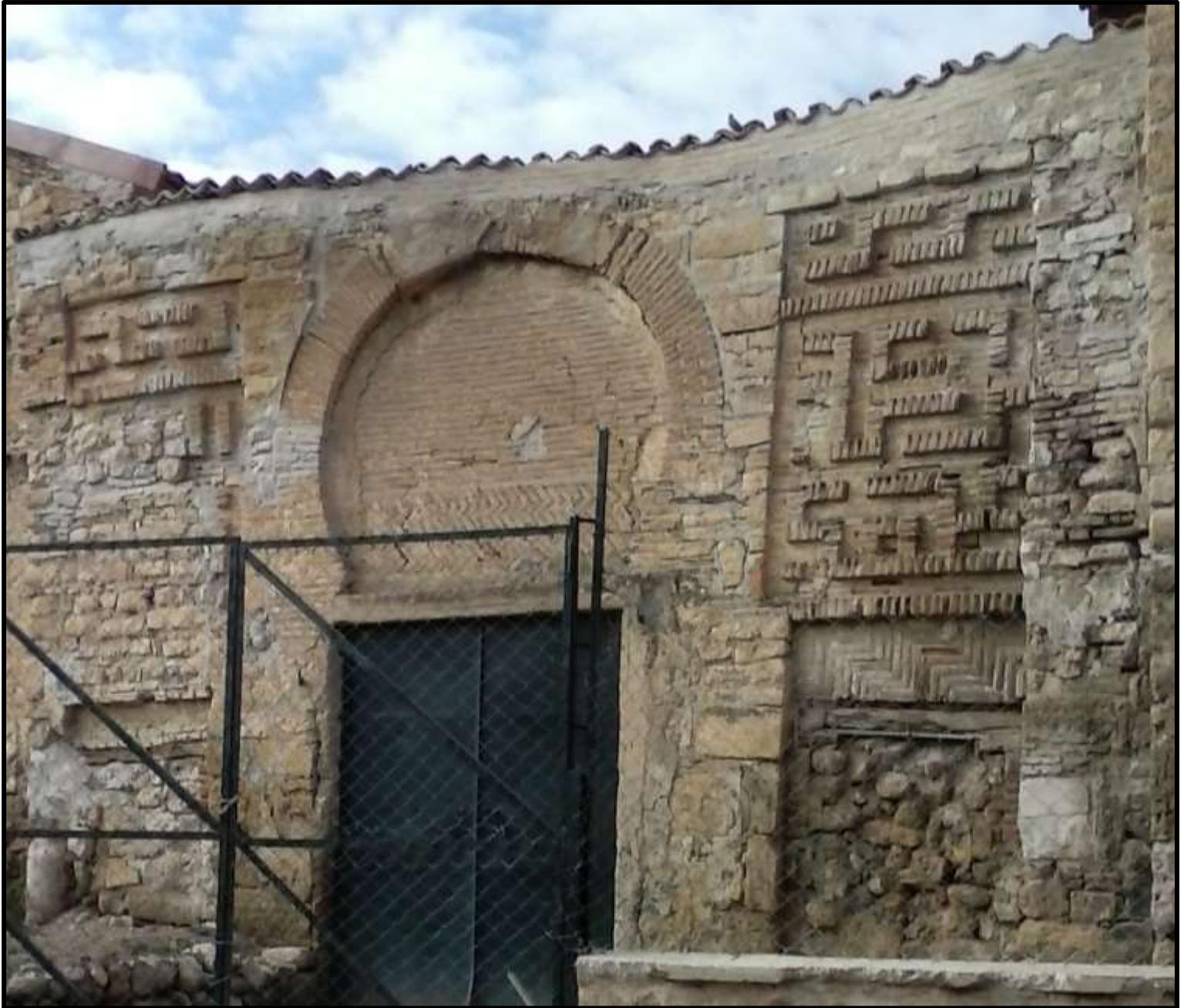
**Figure 227 :** La façade principale de la mosquée Sidi Ghanem où on trouve des décorations calligraphiques Kufiques réalisées en brique de terre cuite sur les deux côtés de la façade, et au milieu de la façade on a un grand arc en plein cintre outrepassé qui surmonte la façade aussi réalisé en brique de terre cuite (Source : Bouhennache Taqiyeddine)
