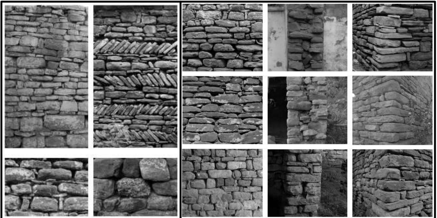
**Figure 29 :** images représentent la structure des différents types de murs en pierre (Source : Manuel de réhabilitation pour la ville de Dellys)
