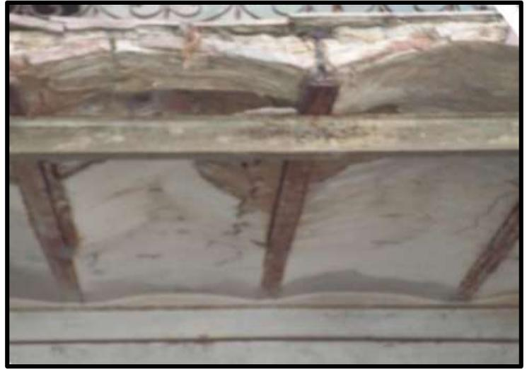
**Figure 161** : L'utilisation de plancher en voutains à Dar Sbitar (Source : ملول اميمة, مذكرة لنيل شهادة الماستر تخصص آثار (اسلامية, مواد وتقنيات البناء بمساكن قسبة ميلة العثمانية, جامعة عبد الحميد مهري بقسنطينة, 2015)
