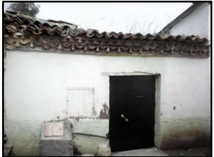
**Figure 226 :** Une corniche en saillie constituée d'une rangé de tuile canal, dont entre chaque deux tuiles une brique de terre cuite est mise perpendiculairement, prise en sandwich entre une double rangé de brique de terre cuite dont l'une des deux incline les briques à 45 degré au-dessus et une autre rangé de brique de terre cuite au-dessous (Source : Bouhennache Taqiyeddine)
