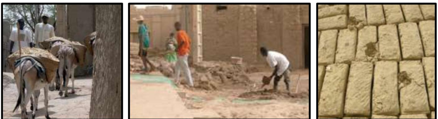
**Figure 65 :** les étapes de fabrication de banco en terre (Source : *Manuel pour la conservation de Tombouctou*)
