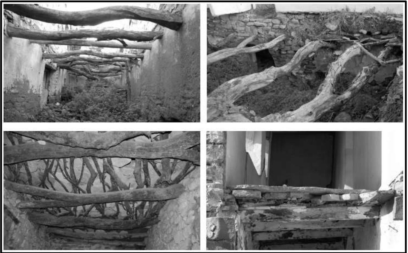
**Figure 33 :** images représentent les différents types de planchers (Source : Manuel de réhabilitation pour la ville de Dellys)
