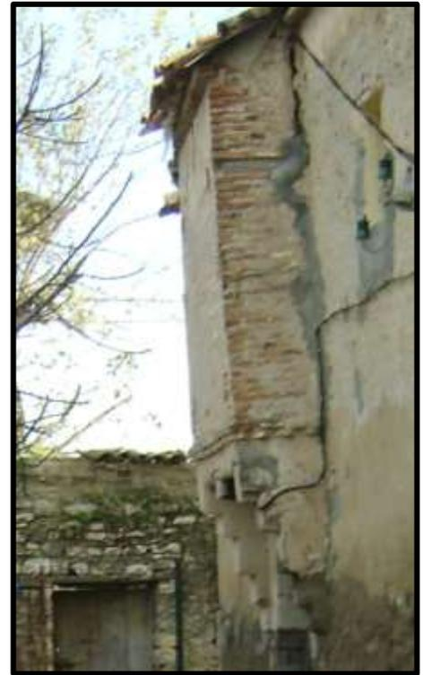
**Figure 177 :** A droite on voit un qbou avec un système constructif à cinq gradins (Source : Bouhennache Taqiyeddine)
