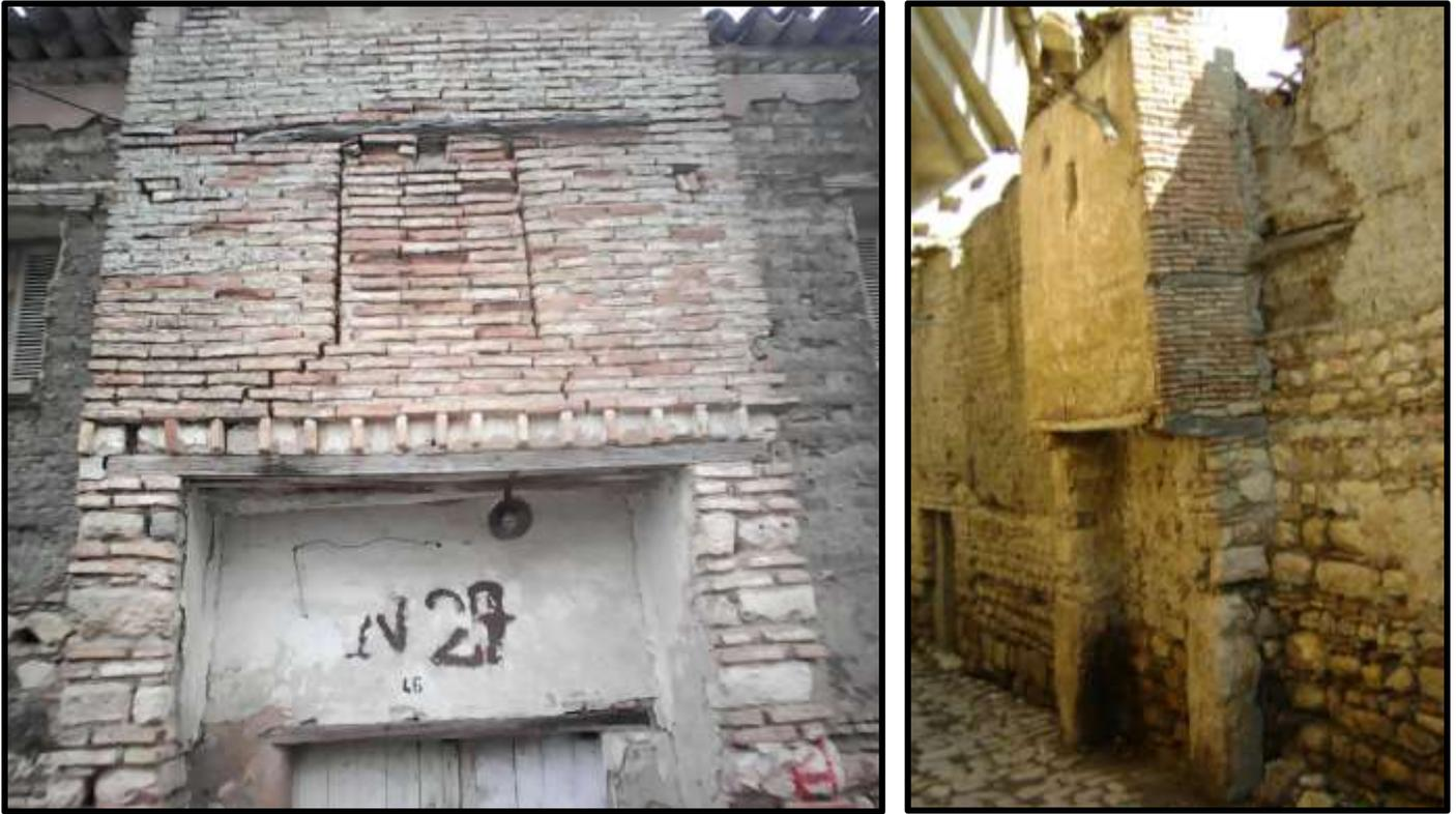
**Figure 179** : Des qbous avec un système constructif constitué de piliers mixtes (Source : Bouhennache Taqiyeddine)
