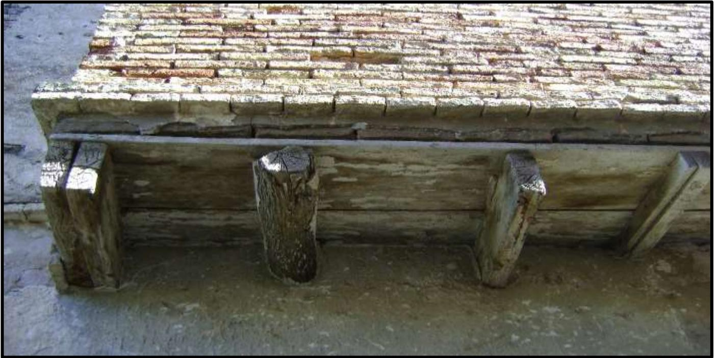
**Figure 171** : Un qbou supporté par des rondins en bois avec deux planches de sections rectangulaires pour constituer sa base (Source : Bouhennache Taqiyeddine)
