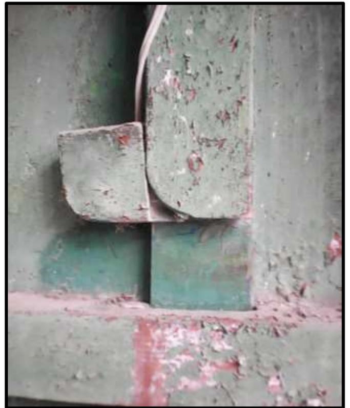
**Figure 195 :** Cet élément a la capacité de se rabattre à 90 degré, dans le sens vertical il garde l'élément de fermeture fixé en état fermé, dans le sens horizontal il permet de l'ouvrir (Source : Bouhennache Taqiyeddine)
