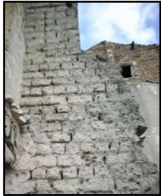
Avant de commencer à mettre les pièce d'adobe sur la partie en pierre de mur, on prépare une surface plane et régulière sur tout le long de mur à l'aide de mortier de terre et de brique de terre cuite.
