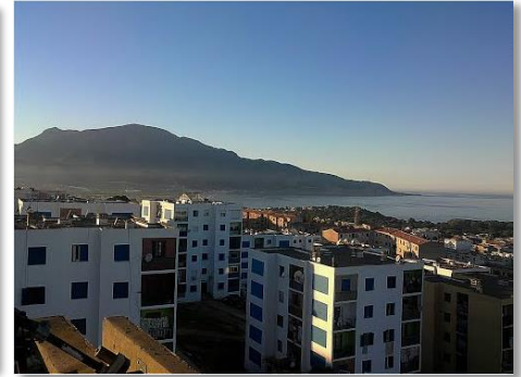
Figure3.49 : photo de la façade/source PHOTO PRISE PAR LE GRP
