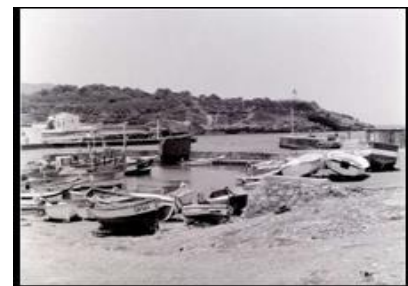
Figure3.19 : aménagement du port
