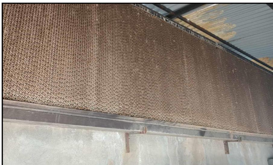
**Figure 19:** système d'humidification pad -cooling (Photo personnelle).
