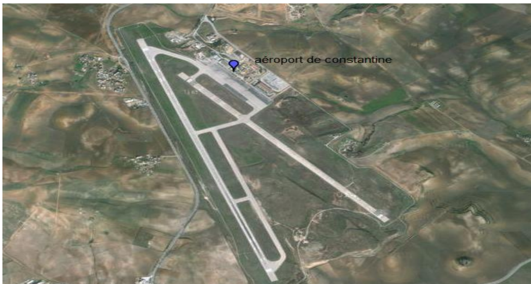
Figure (I.11) : vue par satellite de l'aéroport de Constantine
