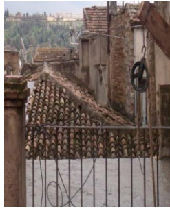
Garde-corps en fer forgé
