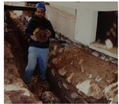
Intervention sur les fondations
