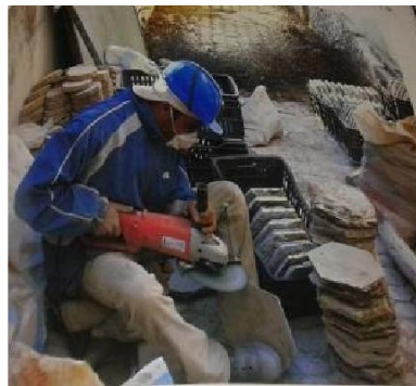
Nettoyage de carreau de marbre
