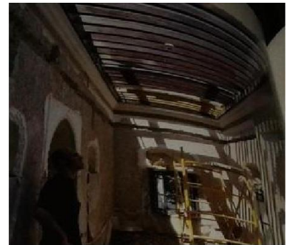
Dépose du plancher traditionnel de la chambre face au hammam.
