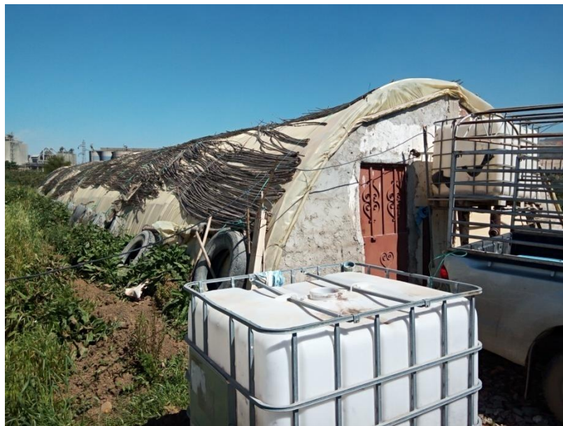
Photo n°2 : Bâtiment d'élevage. (vue d'extérieur )
