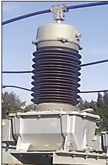
**Figure II. 15.** Transformateur de tension (TT) 60KV – Poste BMR.
