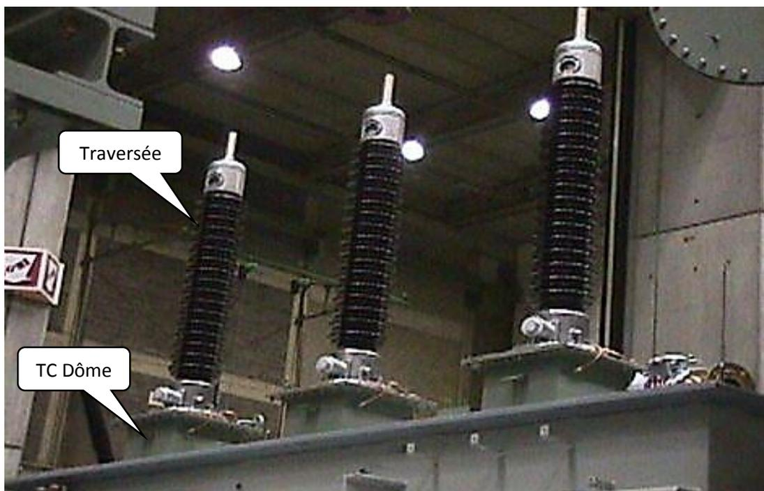
**Figure III. 14.** Traversées (Huile-Air) et TC Dôme du transformateur [34].
