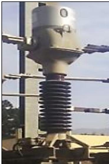
*Figure II. 16.* Transformateur de Courant (TC) 60kV – Poste BMR.
