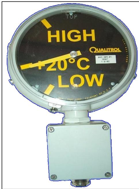
**Figure III. 20.** Indicateur du Niveau d'huile [34].
