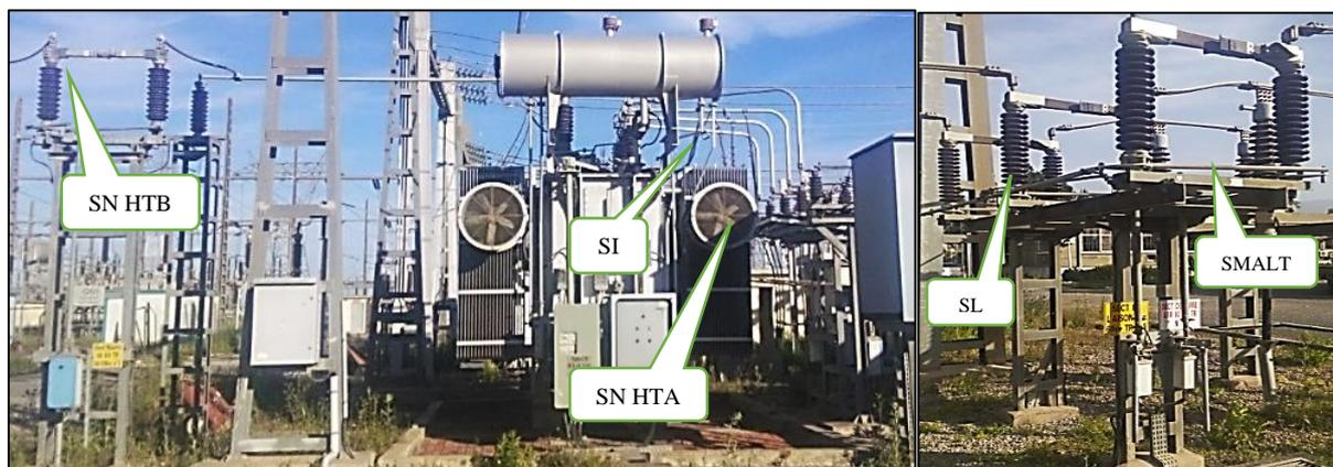
**Figure II. 14. B.** Sectionneurs du TR 60/30KV - Poste BMR.
