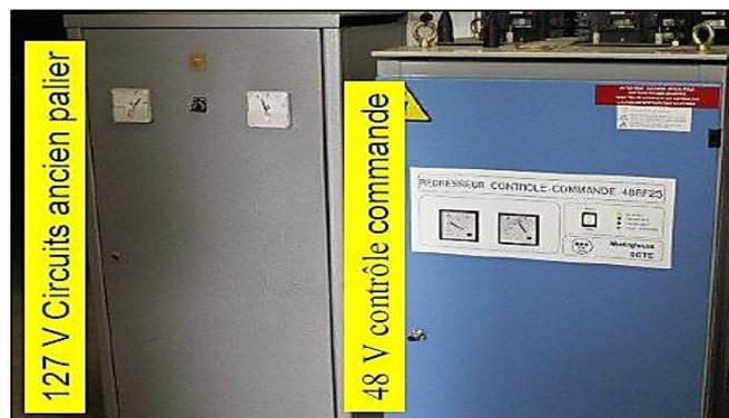
**Figure II-20 :** Les Redresseurs de charge [23].
