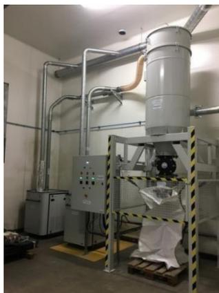
**Figure 14 : Système de dépoussiérage pfc (dépoussiérage au cours de la compression)
