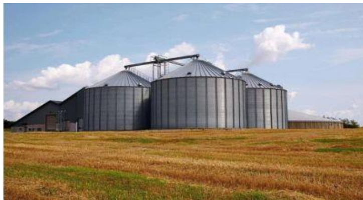
Figure 81 : Silos de stockage
