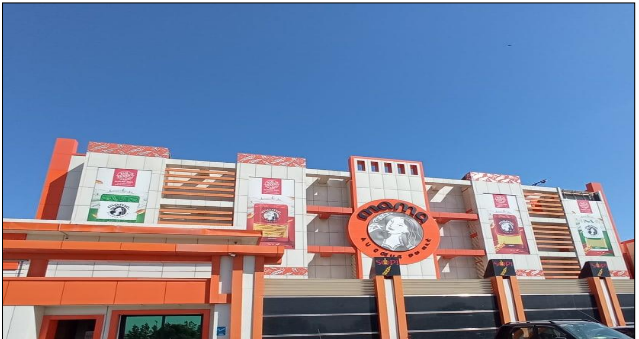
Figure 11 : Entreprise SARL SOPI
