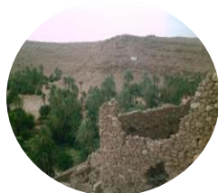
Figure 3.15 Ksar ASLA : Situation : situé à 70 km à l'est d'Ain-Sefra Situé sur une hauteur, il a une porte au nord
