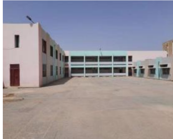
Figure.3.2 :L'espace interne de l'école(la cour du CEM)
