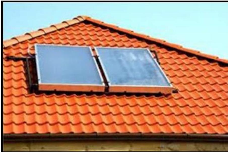
**Figure II-9 :** Chauffe-eau solaire à éléments séparés.
