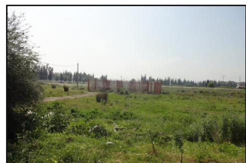
gazoduc (pompe à gaz) source : l'auteur
